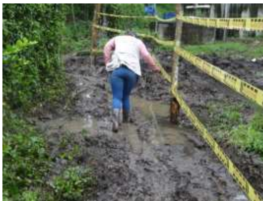
Adecuación del sendero peatonal
