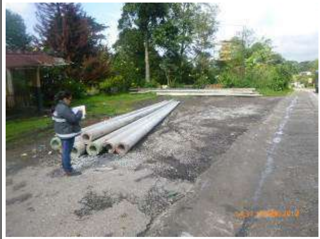
Postes sobre el derecho de vía Km 85+900
