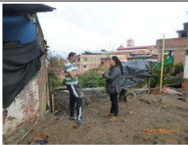
Construcción irregular Km 66+110
