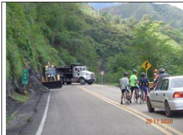
K60+000 Remoción de derrumbe C-CH
