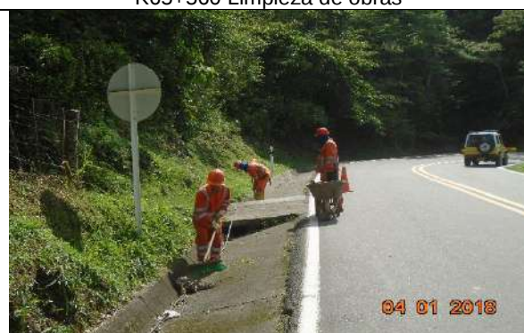
K27+350 Limpieza de cunetas
