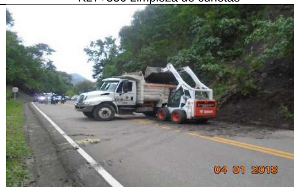
K54+500 Retiro de derrumbe
