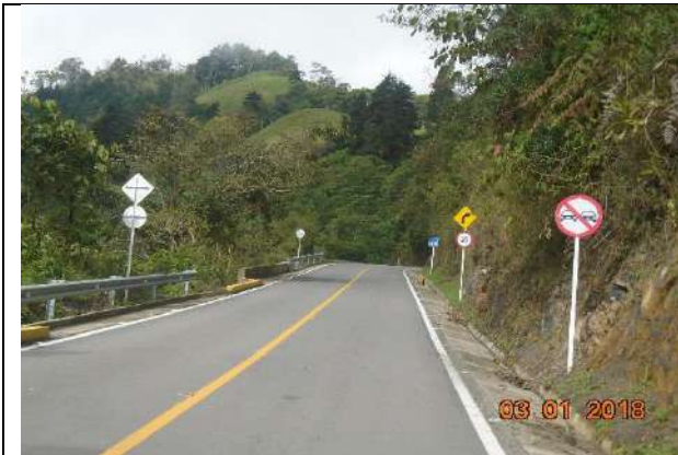
Estado actual de la vía Tabacal – La Sierra.
