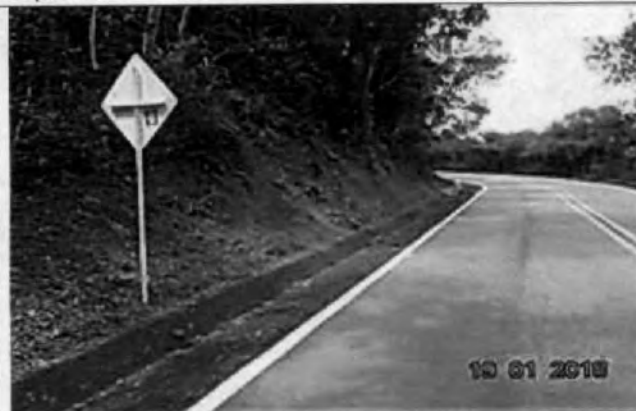
Foto 5. K5+345, limpieza de cuneta, costado izquierdo.
