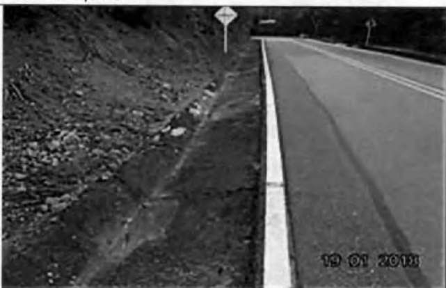
Foto 12. K7+670 al K7+710, limpieza de cuneta, costado izquierdo.
