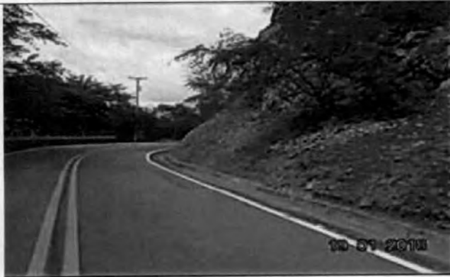
Foto 1. K3+090 al K3+110, limpieza de cuneta, costado izquierdo.
