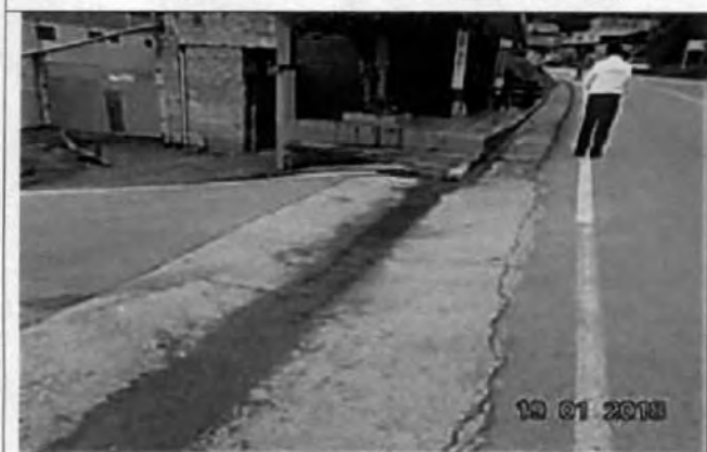
Foto 39. K65+670, cruce carrera 6, solicitud construcción de bordillo.
