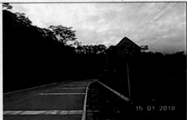
Foto 4. Zona escolar sin la Señalización correspondiente, Tramo Villeta – Alpes.
