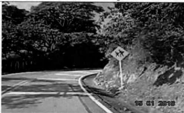
Foto 10. Zona escolar sin la Señalización correspondiente, Tramo Cambao – Chuguacal.
