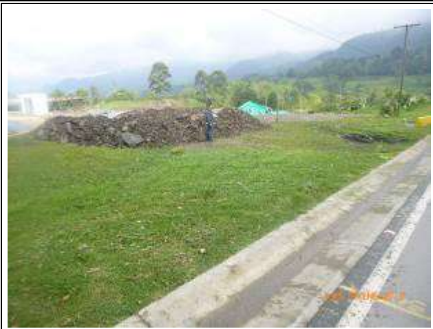
Material sobre el derecho de vía Km 88+310
