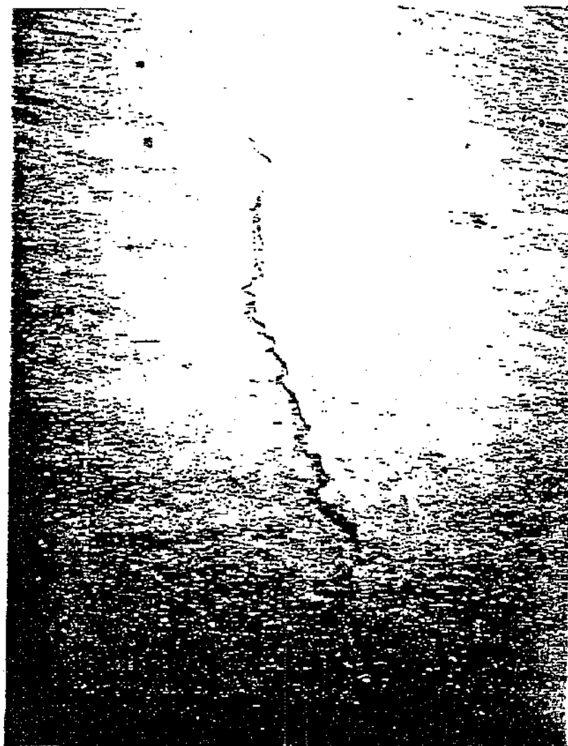
FISURA FORMADA EN UNA SOLA LINEA GENERALMENTE LONGITUDINAL Y AISLADA CON TENDENCIA A RAMIFICARSE
