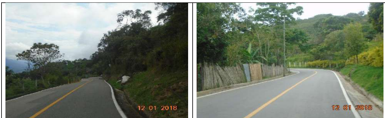
Estado actual de la vía
