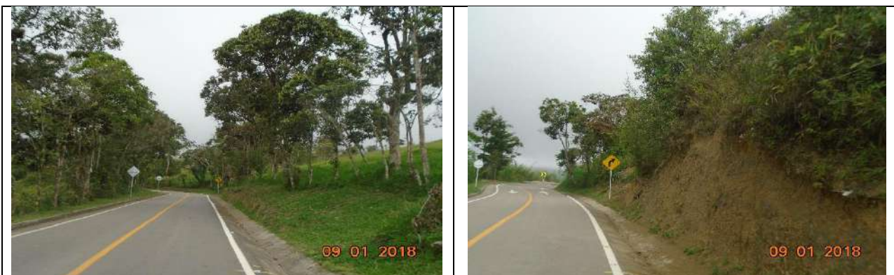
Estado actual de la vía.
