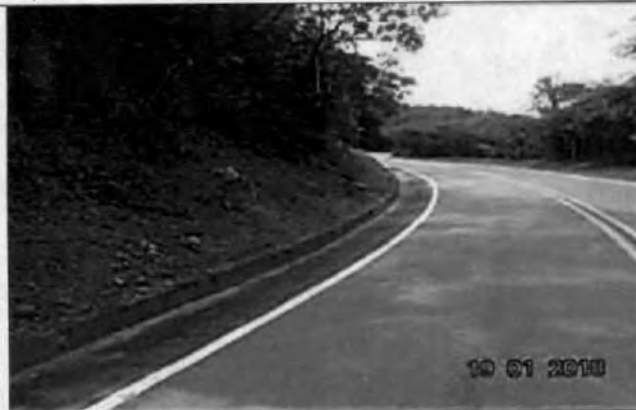
Foto 3. K4+750 al K4+800, limpieza de cuneta, costado izquierdo.
