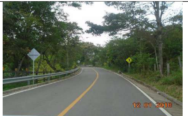
Estado actual de la vía.
