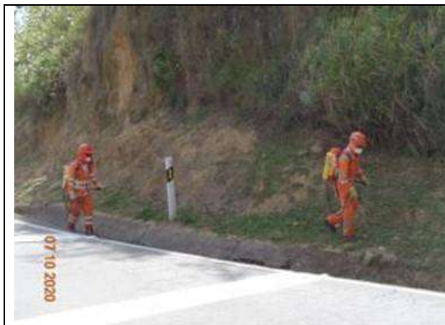
Actividades de limpieza de señales verticales
