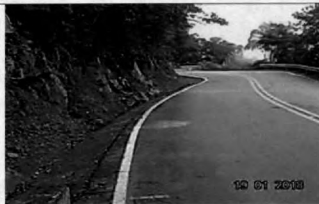
Foto 30. K23+480, retiro de rocas, costado derecho.
