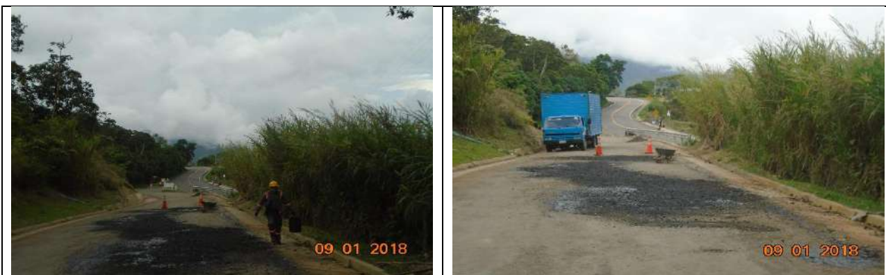
Re nivelación sitio inestable
