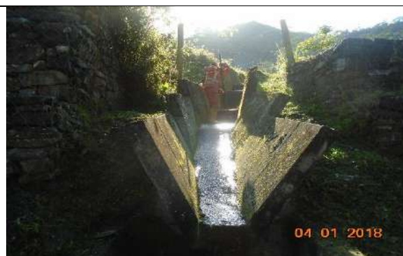
K65+560 Limpieza de obras
