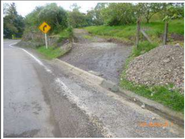
Acceso irregular Km 69+350
