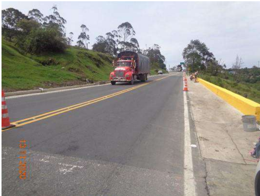
FOTO: K92+413 al K92+453 Obras de Mitigación – Tramo Villeta –Los Alpes
