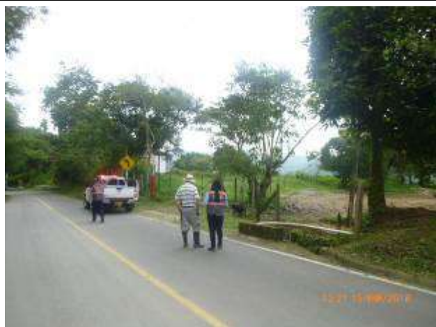
Explanación irregular Km 23+820
