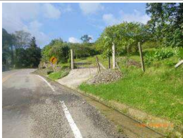
Acceso irregular Km 69+350
