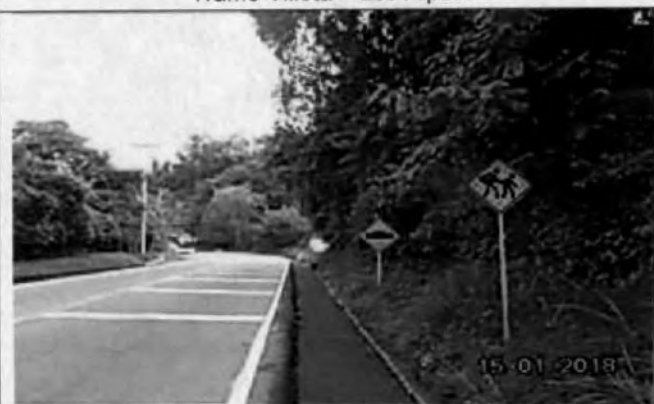
Foto 5. Zona escolar sin la Señalización correspondiente, Tramo Villeta – Los Alpes.
