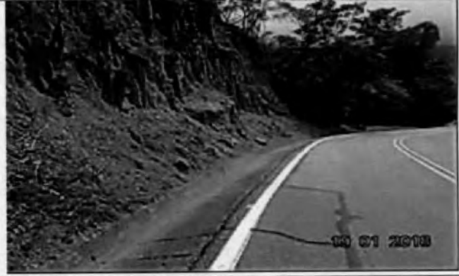
Foto 2. K3+670 al K3+680, limpieza de cuneta, costado izquierdo.
