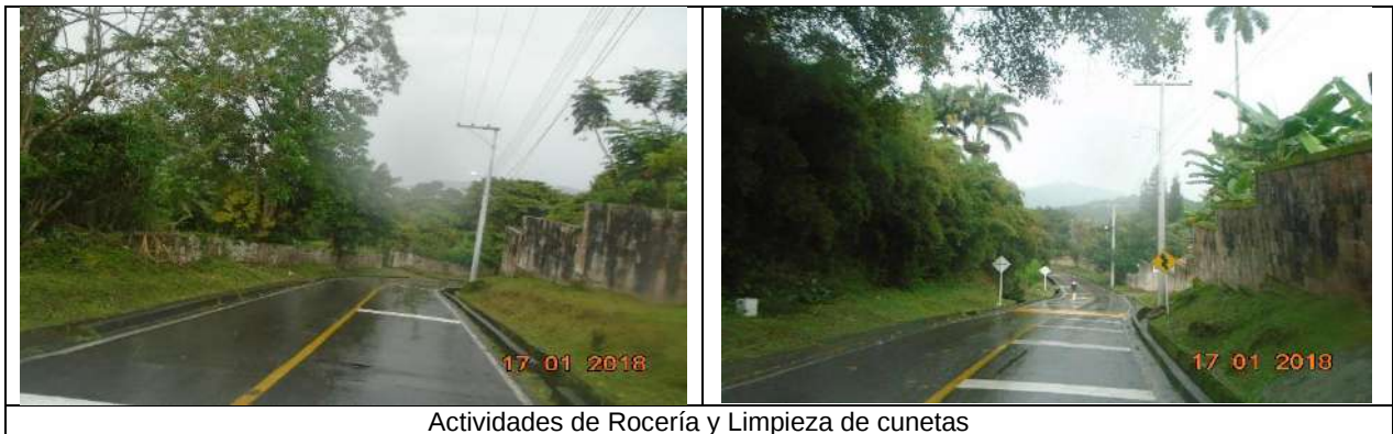
Actividades de Rocería y Limpieza de cunetas
