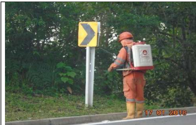
Limpieza de señalización vertical (Tabacal – La Sierra).
