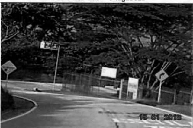
Foto 12. Zona escolar sin la Señalización correspondiente, Tramo Cambao – Chuguacal.
