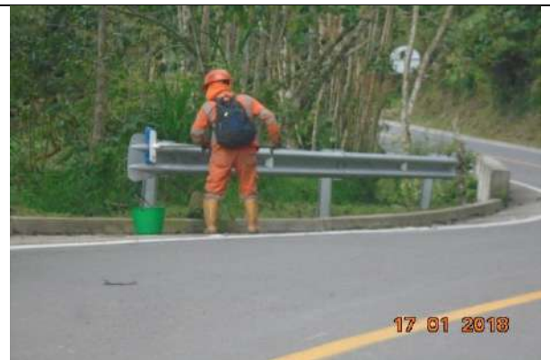
Limpieza de defensas metálicas (Tabacal – La Sierra).
