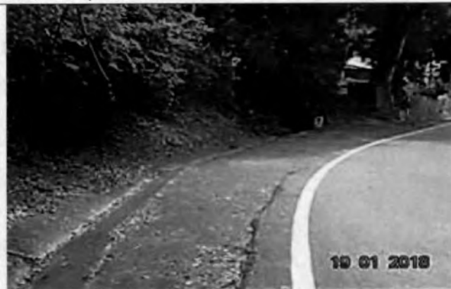
Foto 28. K16+020, retiro de rocas, costado derecho.
