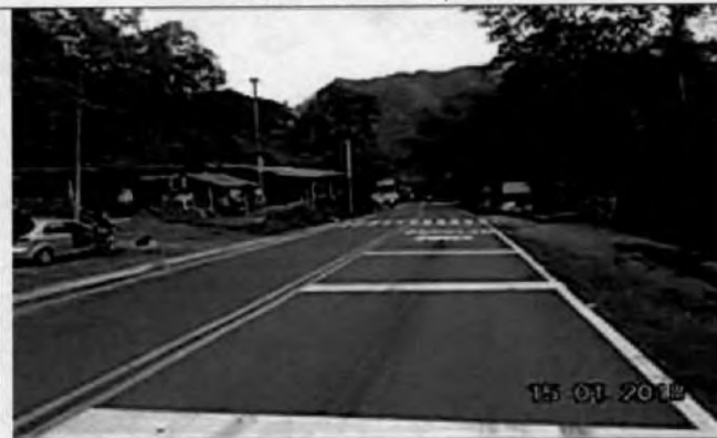
Foto 6. Zona escolar sin la Señalización correspondiente, Tramo Villeta – Los Alpes.
