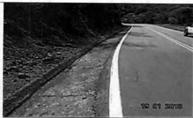
Foto 7. K6+000 al K6+060, limpieza de cuneta, costado izquierdo.
