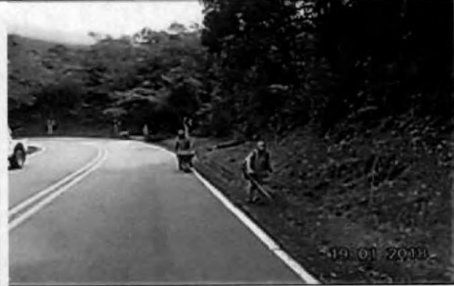
Foto 4. K5+050, limpieza de cuneta, costado izquierdo.
