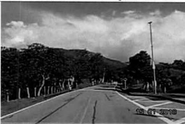
Foto 11. Zona escolar sin la Señalización correspondiente, Tramo Cambao – Chuguacal.
