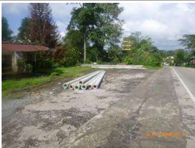
Postes sobre el derecho de vía Km 85+900
