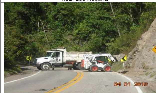
K43+800 Retiro de derrumbe
