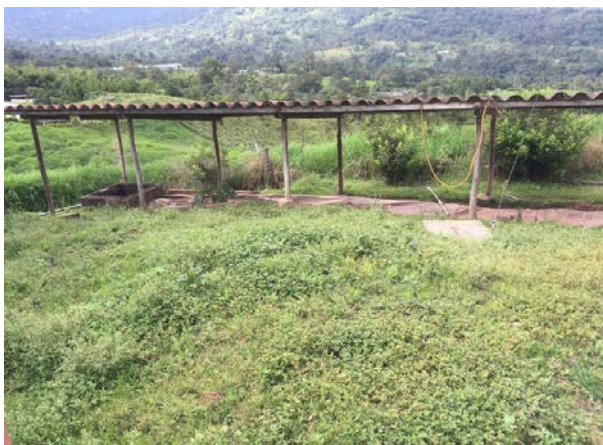
Imagen 12. Biodigestor, E 966456 N 977758. Fuente: Propia
