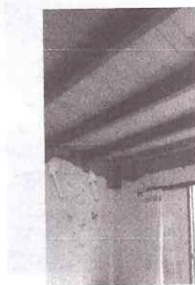
Fotografía 8 Entrepiso de madera. Correa apoyadas en la mampostería
