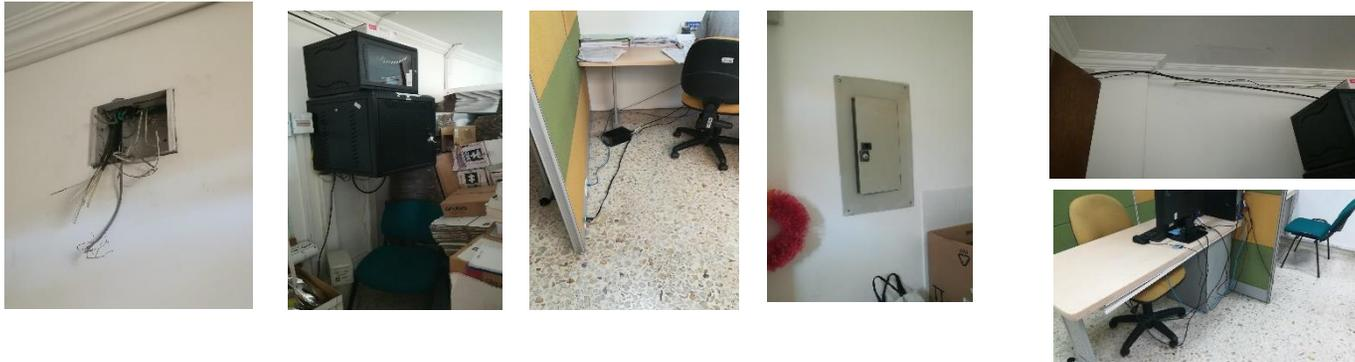
**Peligro identificado:** Condiciones de Seguridad – Eléctrico (Cables expuestos)
