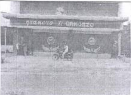
IMAGEN 3. Se aprecia el primer piso del inmueble objeto de la inspección.
