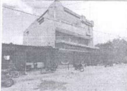
IMAGEN 1. Se observa la calle 26 del barrio la Sabana del municipio de Sabanalarga.
