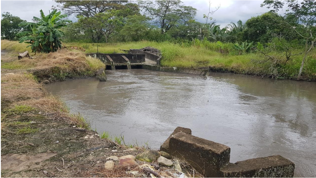
Panoramica general construcciones y obras de adecuacion.
