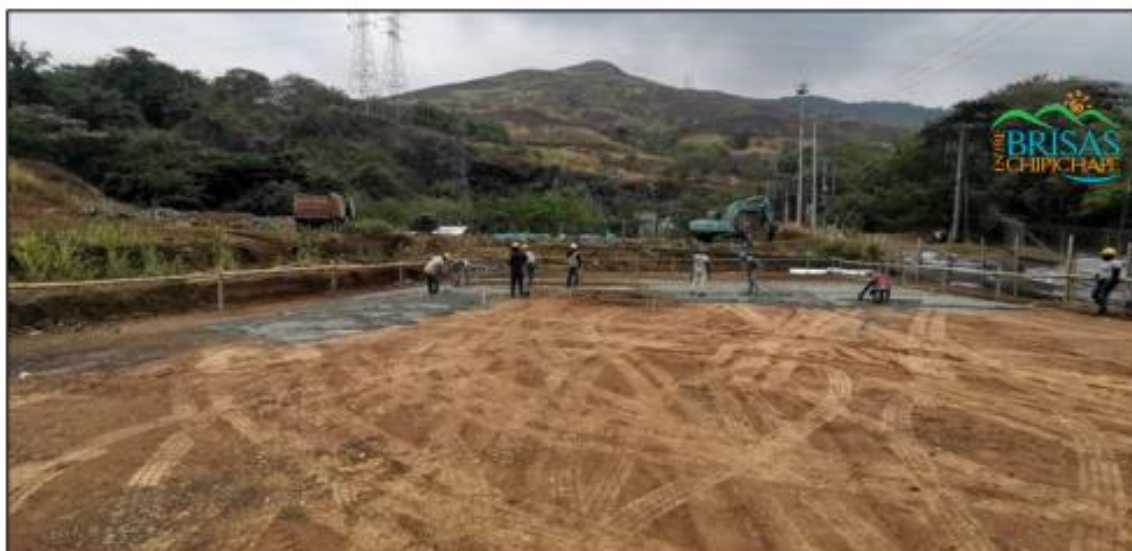
Labores en la Cimentación torre A, Fundición solado de limpieza, para armado refuerzos losa de cimentación.
