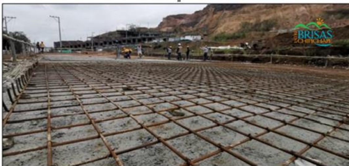
Labores en la Cimentación torre A, Armado refuerzos losa de cimentación.
