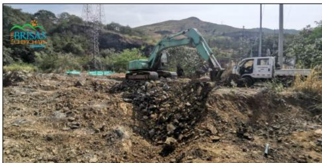
- Excavación sobre roca zona Edificio de parqueaderos.
