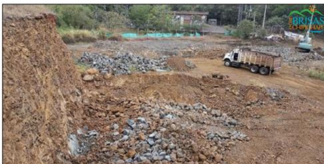
- Movimiento de tierra área edificio de parqueadero.
