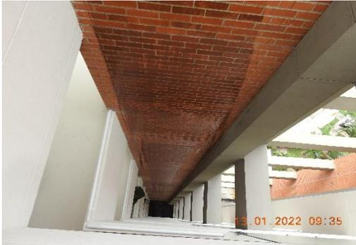
4.Muro lateral cara externa de los cuartos de aseo requiere aplicado de hidrofugo desde el 9° piso hasta el 1°
