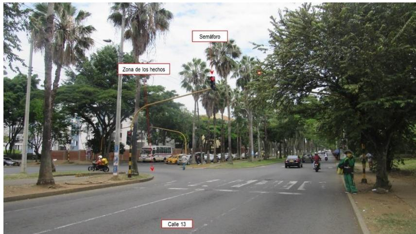
**Fotografía No.6 Plano General** fotografía tomada sentido Norte - sur, donde se observan las características generales del tramo de vía recta, plana, estado bueno, único sentido de circulación, demarcación horizontal línea de borde blanca y amarilla, separadora de carril segmentada, doble calzada, Señalización vertical, SP-46 zona de peatones, semáforo. En este sentido se desplazaban los involucrados.
