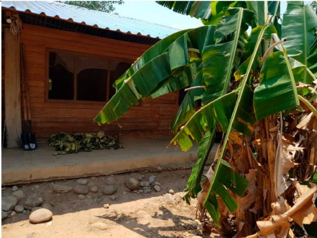
IMG 2 Vista lateral de la construcción
