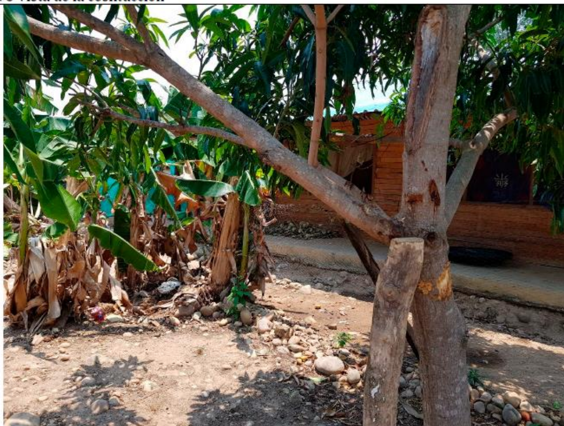
IMG 4 Vista lateral de la construcción
