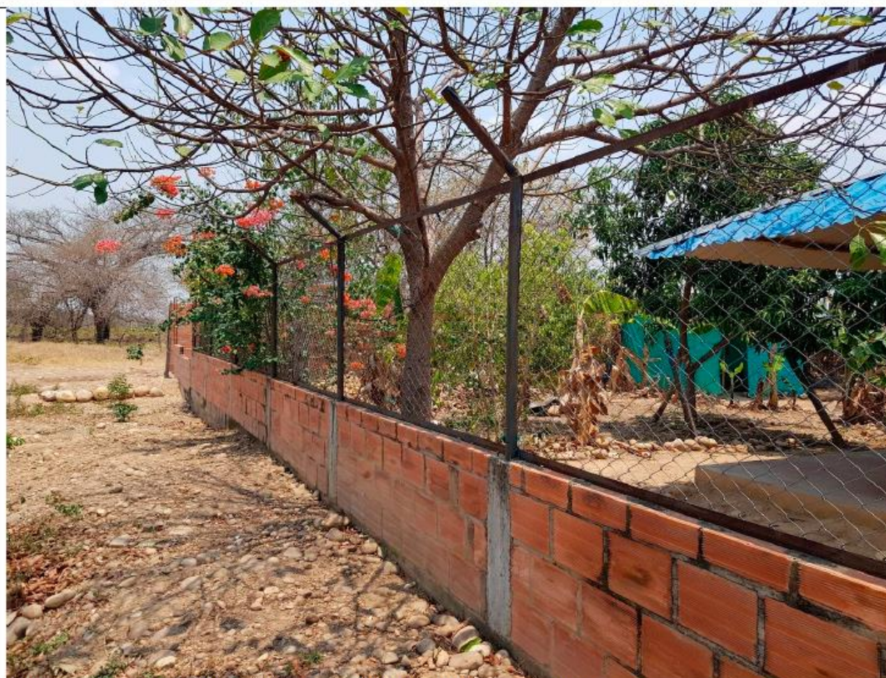
IMG 5 Vista del muro en bloque de maguncia y malla eslabonada
