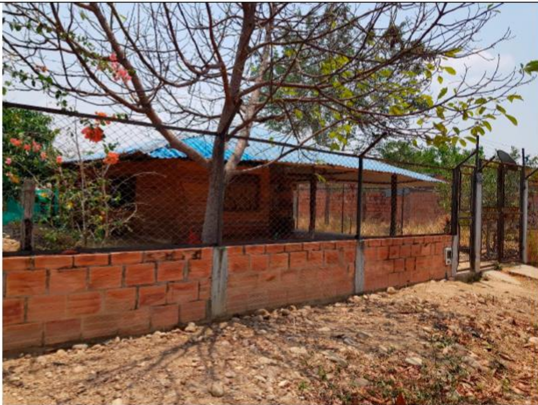
IMG 1 frente del inmueble en estudio y vista de la construcción en el existente
