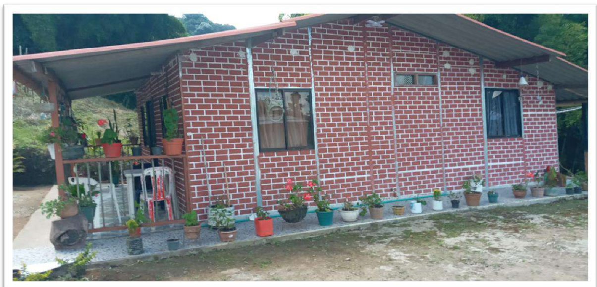
Foto 2. Casa de habitación de estilo campestre, Fachada lateral derecha, del predio Pila de Agua , objeto solicitado en pertenencia.
