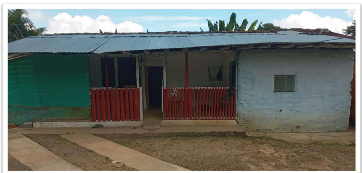
Foto 5. Casa de habitación de estilo campesino, Fachada posterior, del predio Pila de Agua , objeto solicitado en pertenencia.
