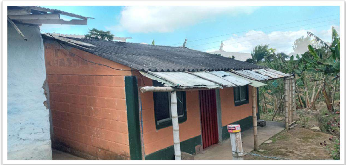
Foto 3. Casa de habitación de estilo campesino, Fachada posterior, del predio Pila de Agua , objeto solicitado en pertenencia.
