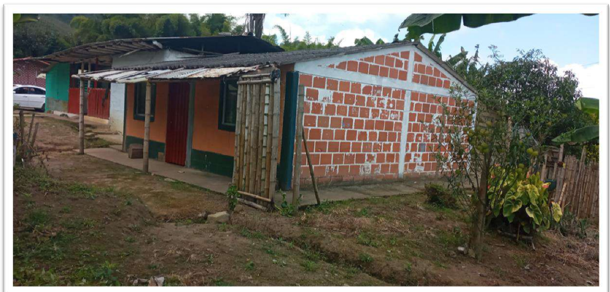
Foto 4. Casa de habitación de estilo campesino, Fachada posterior, del predio Pila de Agua , objeto solicitado en pertenencia.
