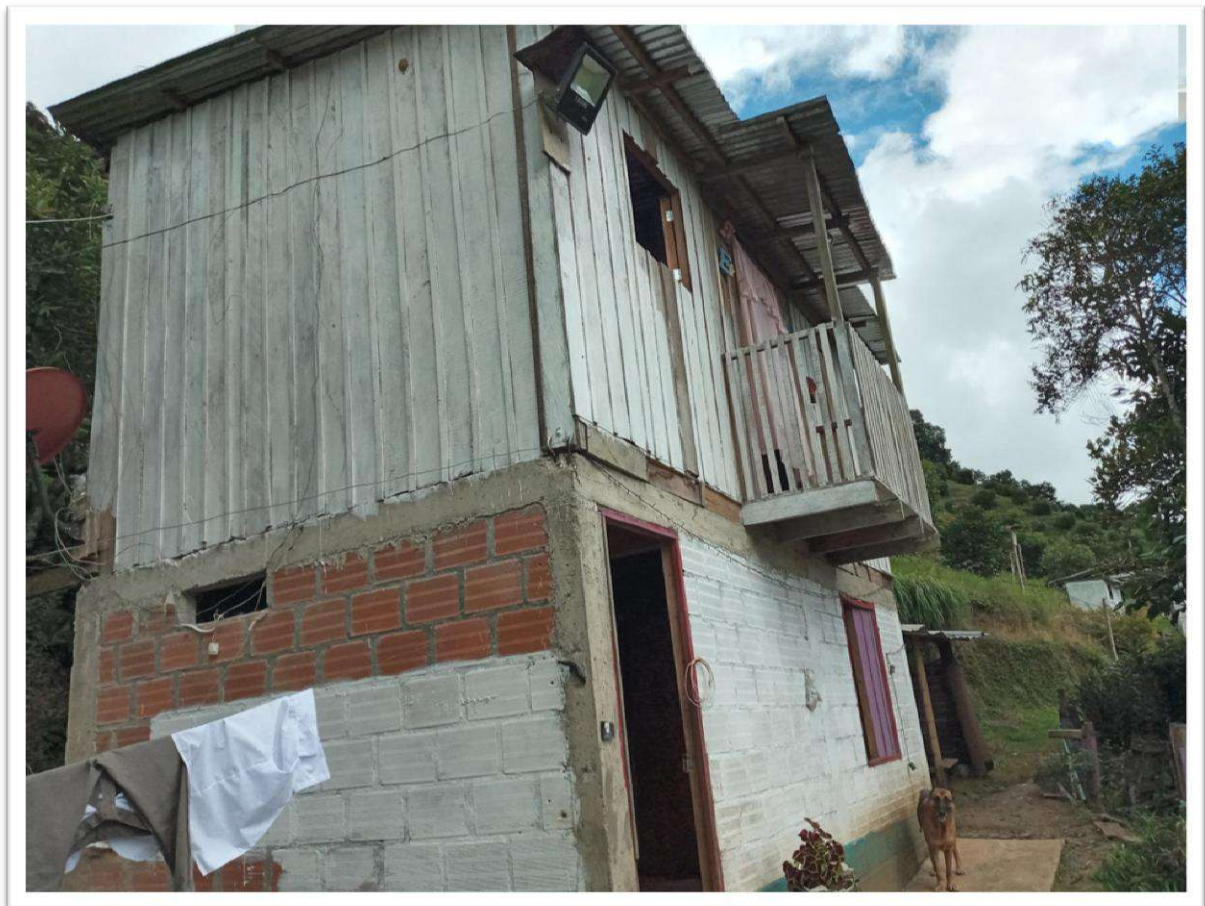
Foto 3. Una casa de habitación de estilo campesino, de dos plantas, que está construida en paredes de ladrillo Farol y madera.
