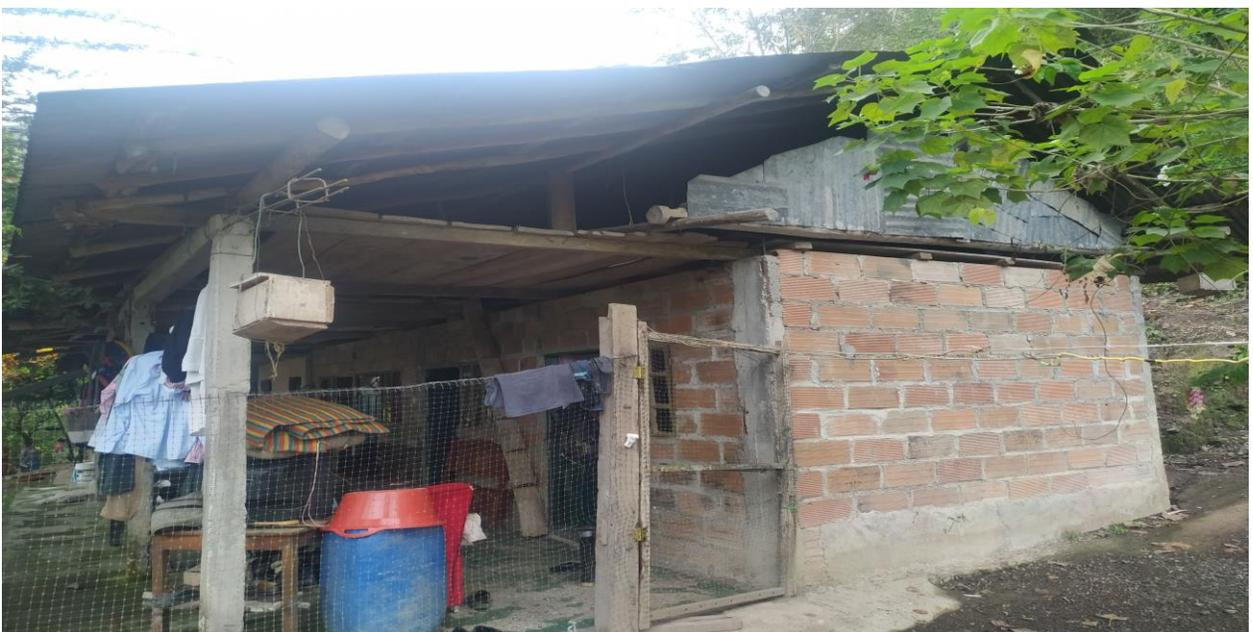
Cuenta con los servicios sanitarios (Lavadero, Baño, Ducha y tanque de almacenamiento de agua construido en bloque de cemento revocado) con unas dimensiones de 5 x 2 metros para un total de 10 m<sup>2</sup> construidos por paredes de Bloque revocado y concreto fundido; estas construcciones cuentan con el servicio de Agua por gravedad y no cuenta con el servicio de energía eléctrica monofásica.
