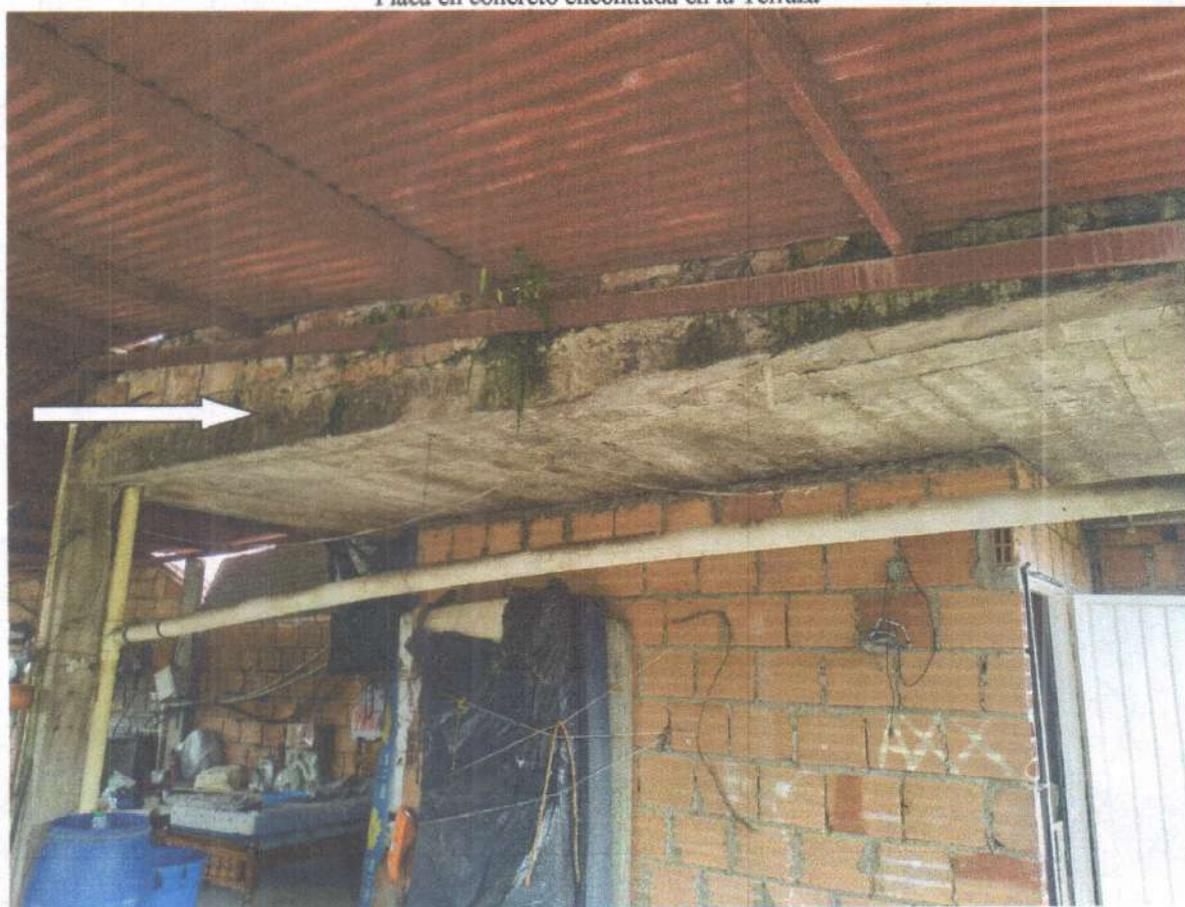
En la parte posterior del lote de terreno o Solar se encuentra una construcción o Garaje con unas dimensiones de 3,40 metros de frente por 5,40 metros de fondo; construido con pisos de concreto fundido, Muros en Columnas de Ferro concreto fundido y ladrillo H10 y su cubierta en laminas de zinc sostenida por estructura de madera.
