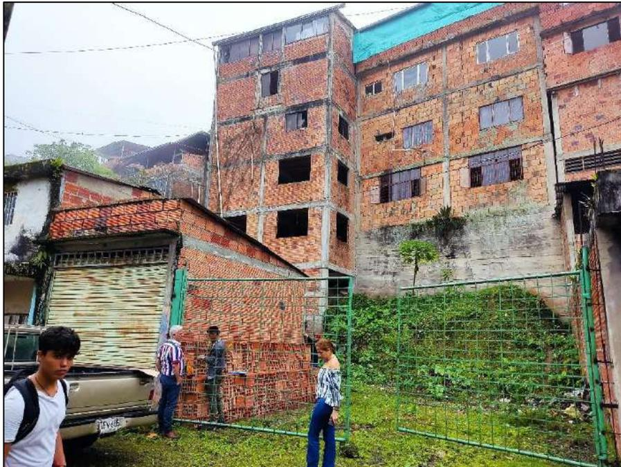
**CONSTRUCCION PEQUEÑA:** Con dimensiones de 3.41 metros por 5.41 metros de fondo con paredes levantadas en ladrillo H10 con techo en teja de Zinc, puerta metálica
