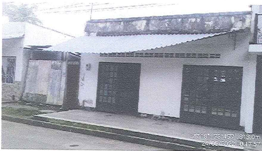
Fachada del predio
