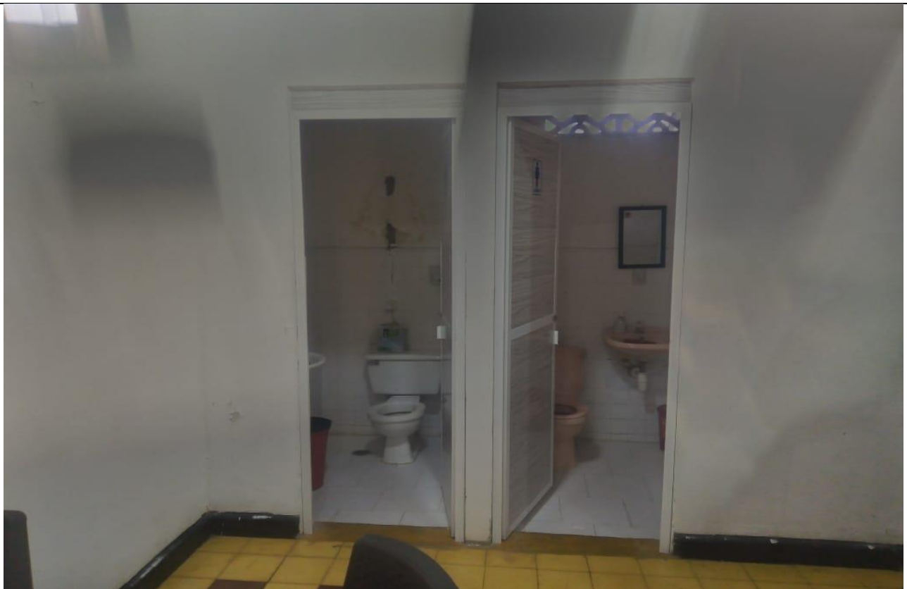
PANORAMICA FRONTAL DE SANITARIOS
