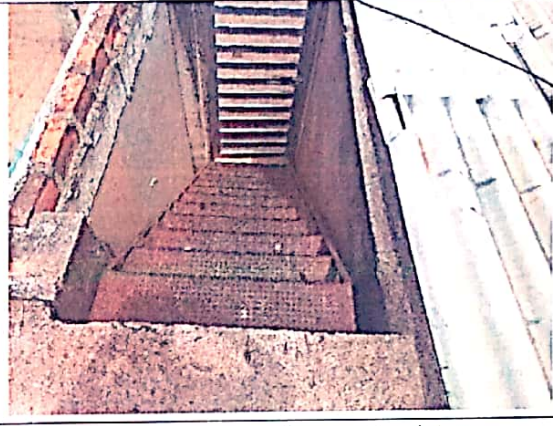
Puerta acceso metalica y escaleras
