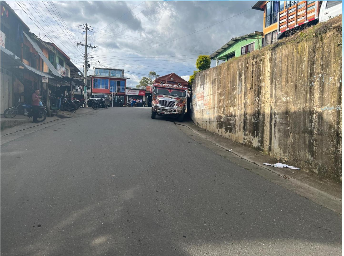
En esta imagen fotográfica, tomada desde la parte anterior del vehículo, se puede apreciar cómo se encuentra bien pegada al muro de contención el bus escalera, en la misma imagen se evidencia que se trata de una vía curva, con pendiente, sin demarcación alguna, con cuneta para ambos costados y berma para un solo lado de la vía.
