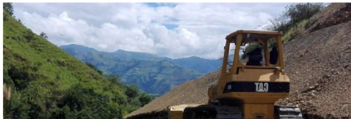
Colocación del relave seco en el depósito.
