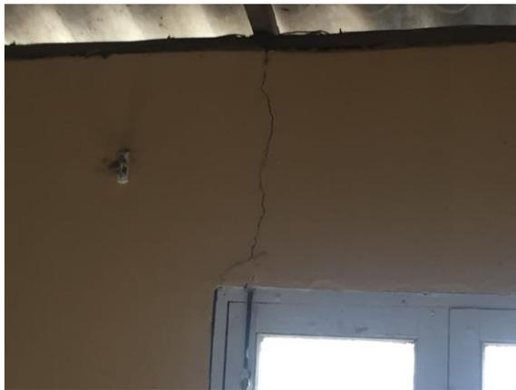
**Presencia de grieta. Formación por ausencia de viga de amarre y dintel en ventana. Malos procesos constructivos. Mantenimiento ineficiente, se evidencia reparación, pero si grapas.**
