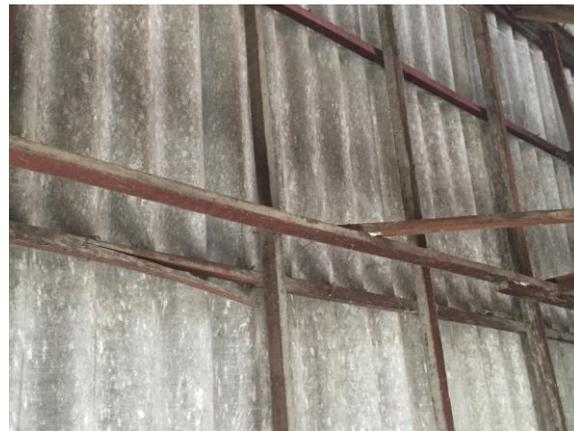
**Estructura en madera la cual sostiene láminas de techo. Se evidencia fractura de madera por la acción de la intemperie y falta de inmunización (curar) de la misma, existe la actuación de Comején.**
