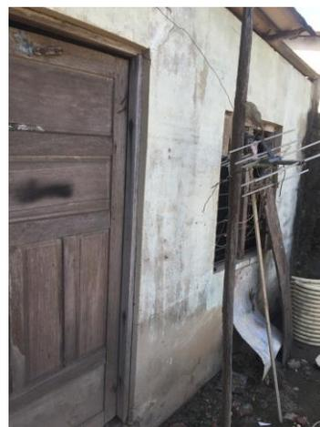
Presencia de humedad en todo el inmueble, lo que genera fisuras y grietas en muros y pisos. Se evidencia malos procesos constructivos y falta de mantenimiento.
