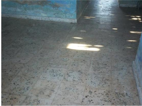
**Piso sala. Presencia de fisuras. Se evidencia humedad en muro. Falta de mantenimiento.**
