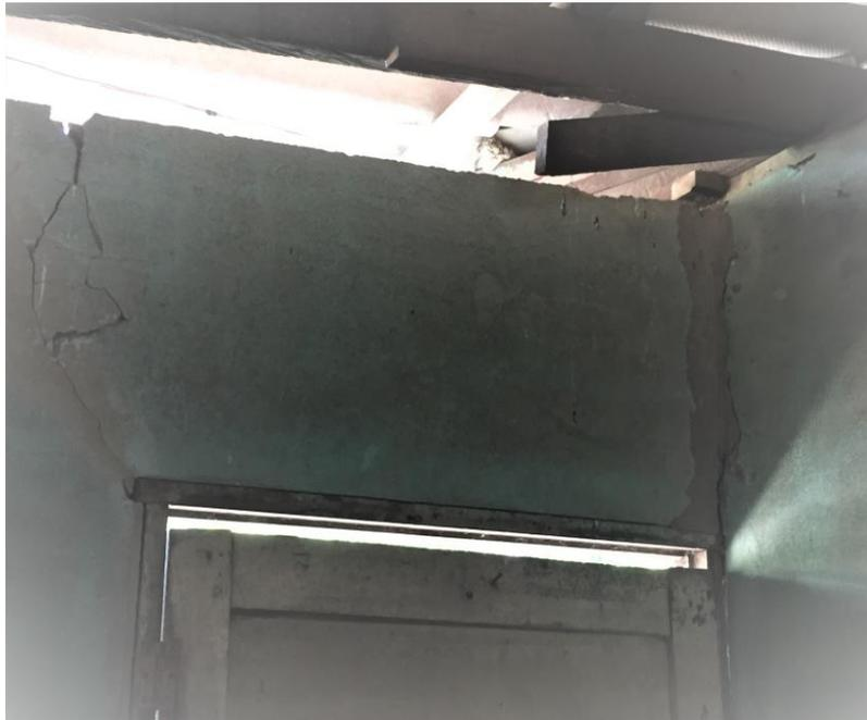
Se evidencia fractura en muro y junta de dilatación entre muros, a causa por la ausencia de dintel y viga de amarre para que la estructura trabaje por uno solo.
