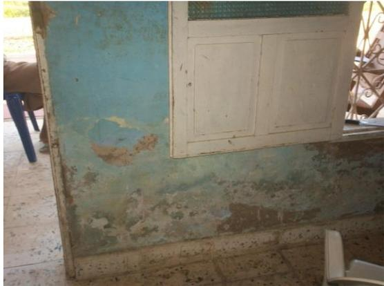
**Muro sala, ventana de fachada, presencia de humedad. Falta de mantenimiento.**
