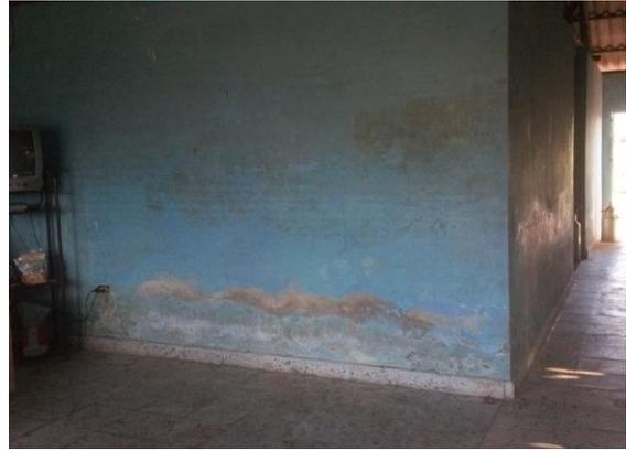
**Muro sala, presencia de humedad. Se evidencia humedad en muro de corredor. Falta de mantenimiento. Ausencia de vigas de amarre, columnas y dinteles.**
