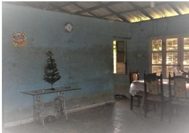
**Sala comedor. Muros presencia de humedad en sus bases. Se evidencia ausencia de columnas, vigas de amarre y dinteles. Presencia de especie vegetal en muro de ventana de comedor, incrementa humedad, lo que origina fisuras y grietas en pañete.**
