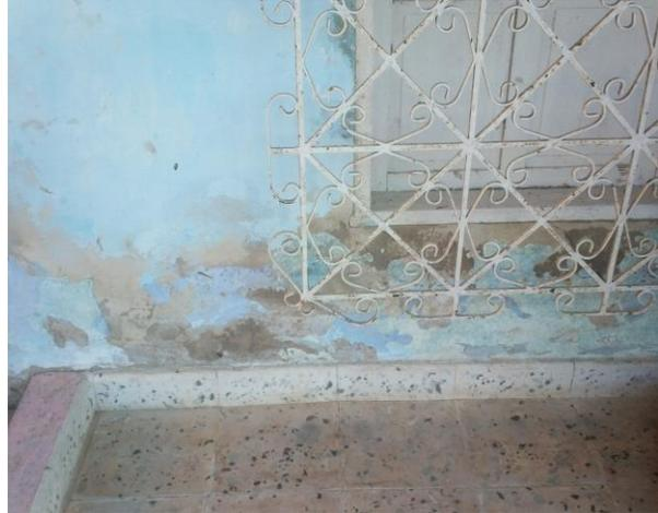
**Fachada, ventana alcoba principal, presencia de grietas y fisuras por acción de humedad, falta de mantenimiento.**
