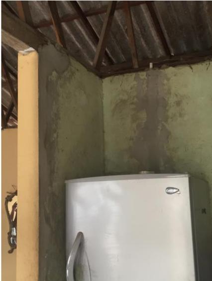
Se evidencia reparación de grietas, las cuales nacen por falta de viga que amarre los dos muros.
