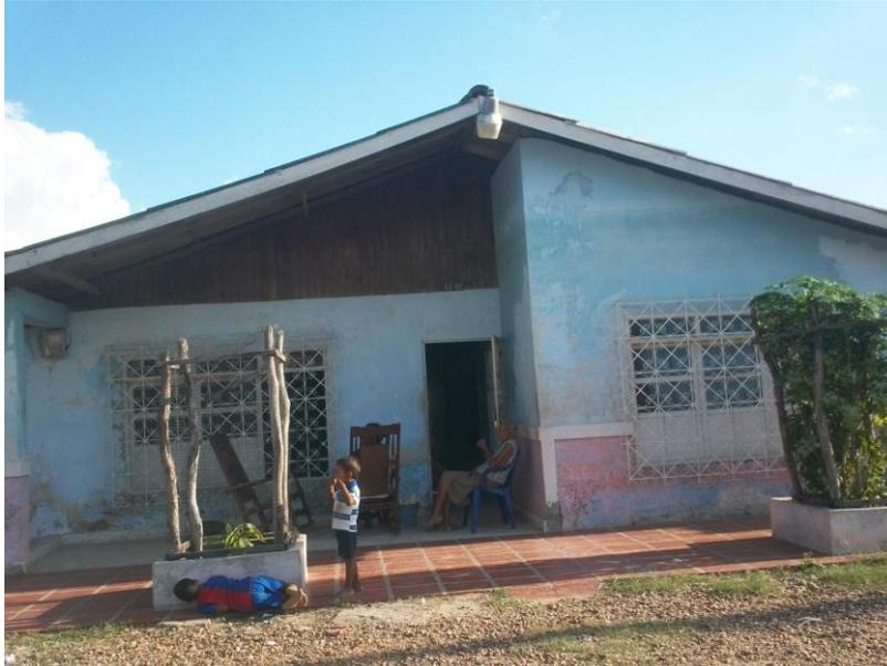
**Fachada. Evidencia ausencia de columnas, vigas y dinteles. Alta presencia de humedad en toda la fachada. Falta de mantenimiento.**
