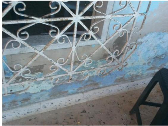
**Fachada, ventana alcoba principal, presencia de grietas y fisuras por acción de humedad, falta de mantenimiento. Ausencia de "Dintel".**
