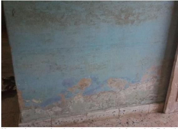
**Muro sala, entrada principal, presencia de humedad. Falta de mantenimiento.**
