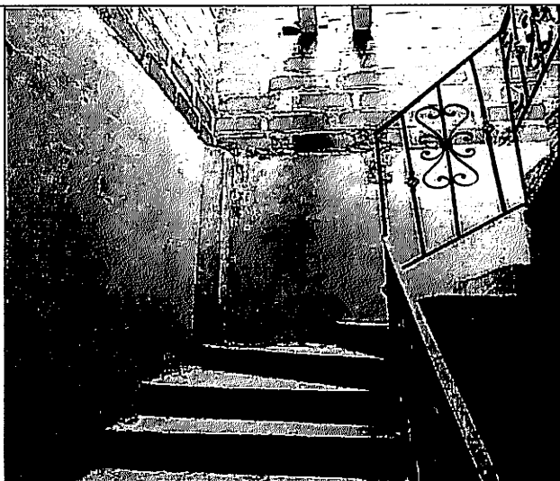
ESCALERAS DE ACCESO
