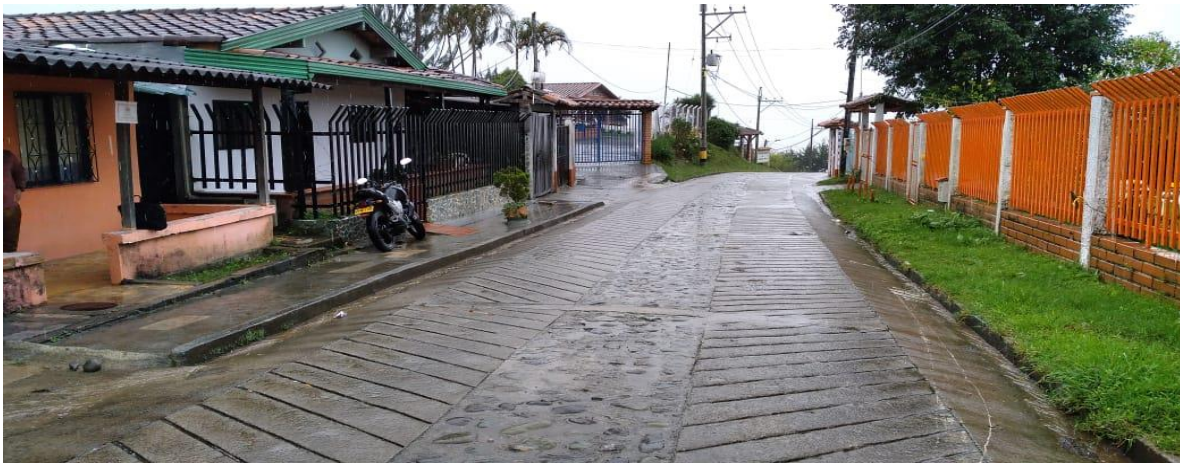
ACCESO POR TERRENO PARTICULAR
