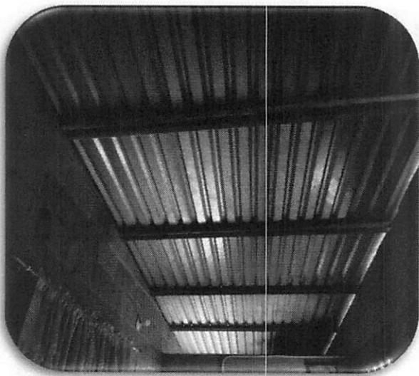
Observamos la cubierta en perfil metálico y teja metalde.
