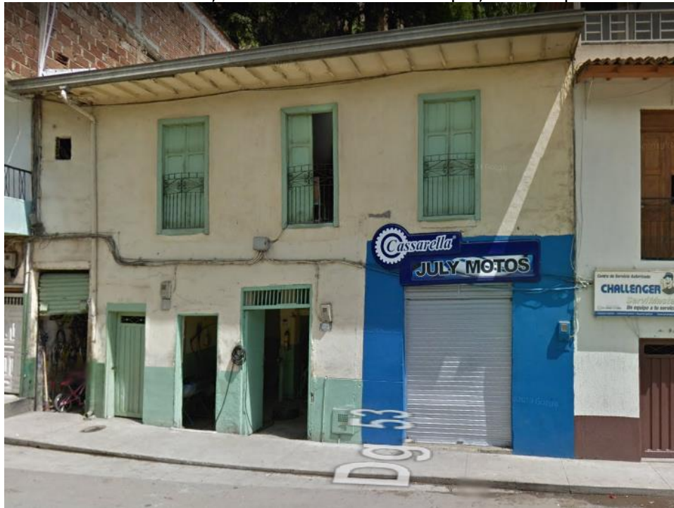
Foto 6: Vista del frente del predio avaluado apartamento 201 y locales comerciales, vía Diagonal 53 por el lado oriental de la construcción estado de conservación antes de realizar las adecuaciones, se observa fallada en tapia, bahareque.
