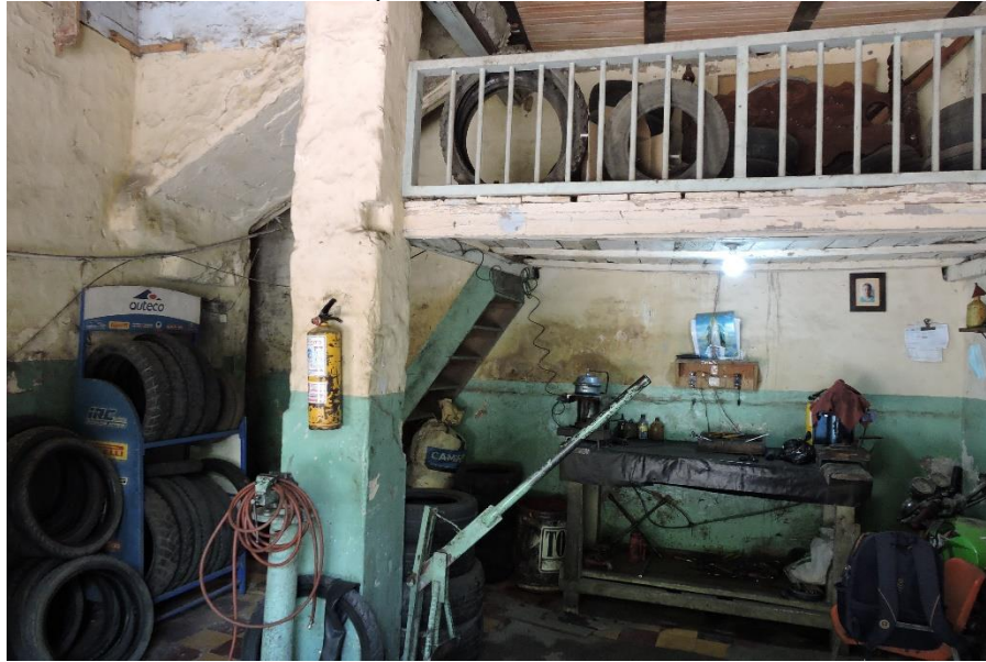
Foto 3: Vista al interior local 102 Taller Monta Llantas, paredes en tapia, bahareque ladrillo, piso en cemento.
