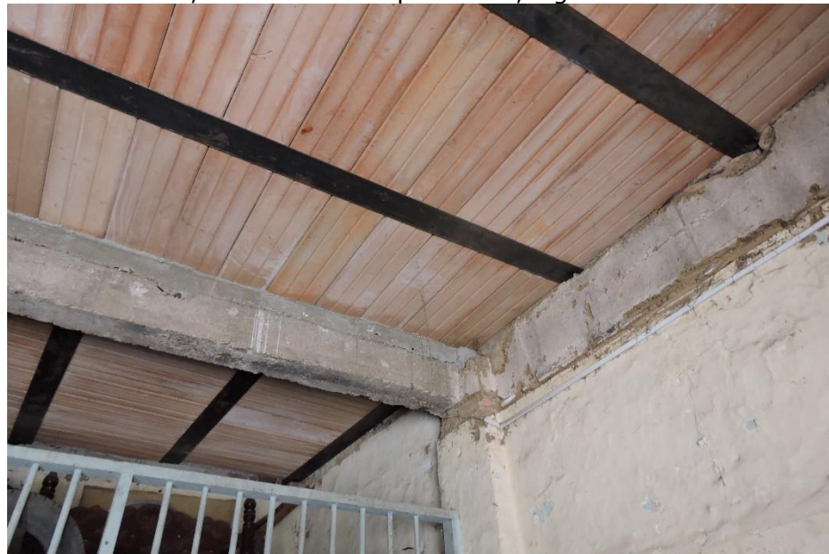
Foto 4: Otra vista al interior local 102 Taller Monta Llantas, paredes en tapia, bahareque ladrillo, cubierta el losa placa fácil, vigas de amarre.
