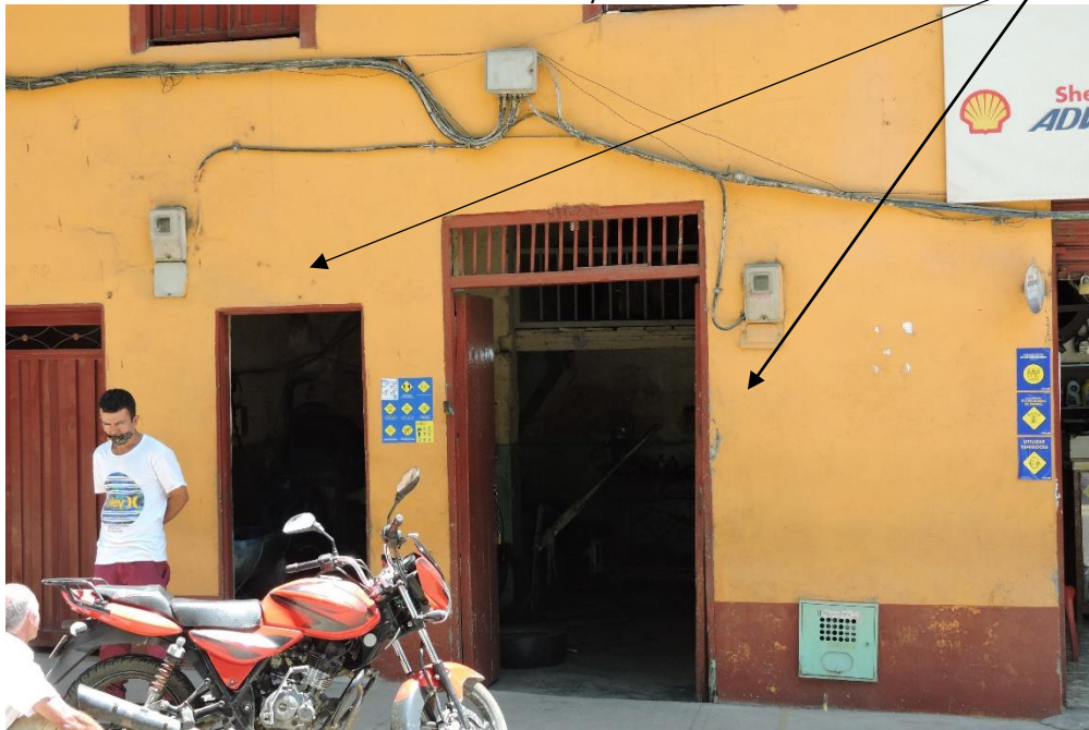
Foto 2: Vista al acceso para el local 102 Taller Monta Llantas, dos puertas de acceso desde el primer piso por la Diagonal 53, lado oriental del inmueble con FMI 004-39385. Nomenclatura N. 50-86/88
