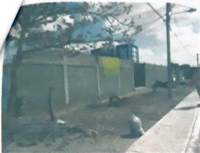
VISTA ENTORNO OESTE-ESTE
