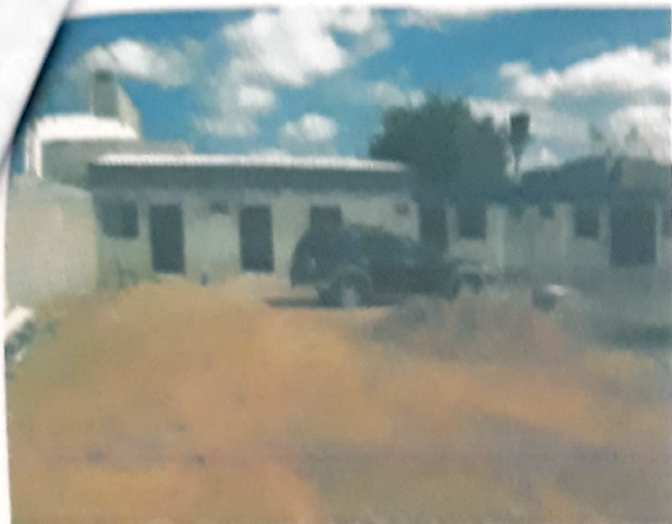
VISTA FACHADA HABITACIONES-AREA PARQUEOS VEHICULOS
