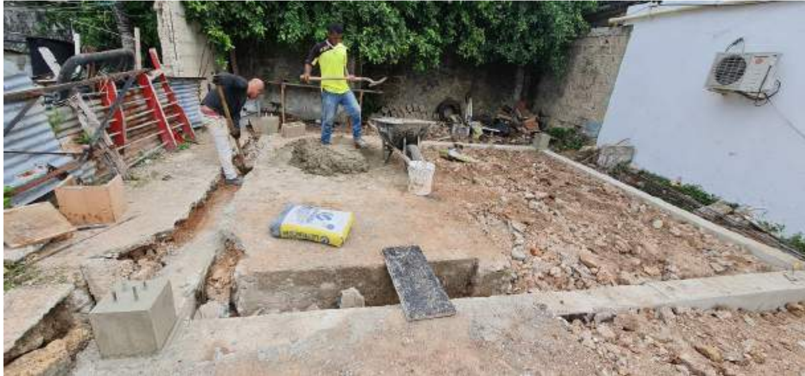
DESENCOFRADO DE PEDESTALES E INICIO DE PEGA DE CONTORNO
