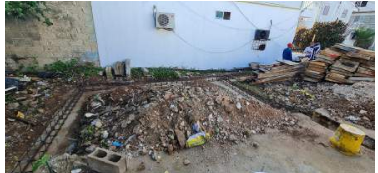
VISTA LONGITUDINAL, TRASLAPOS NO MENOR A 80 CM
