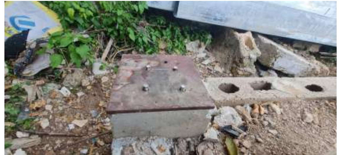
LAMINA DE ½ PARA BASE COLUMNAS
