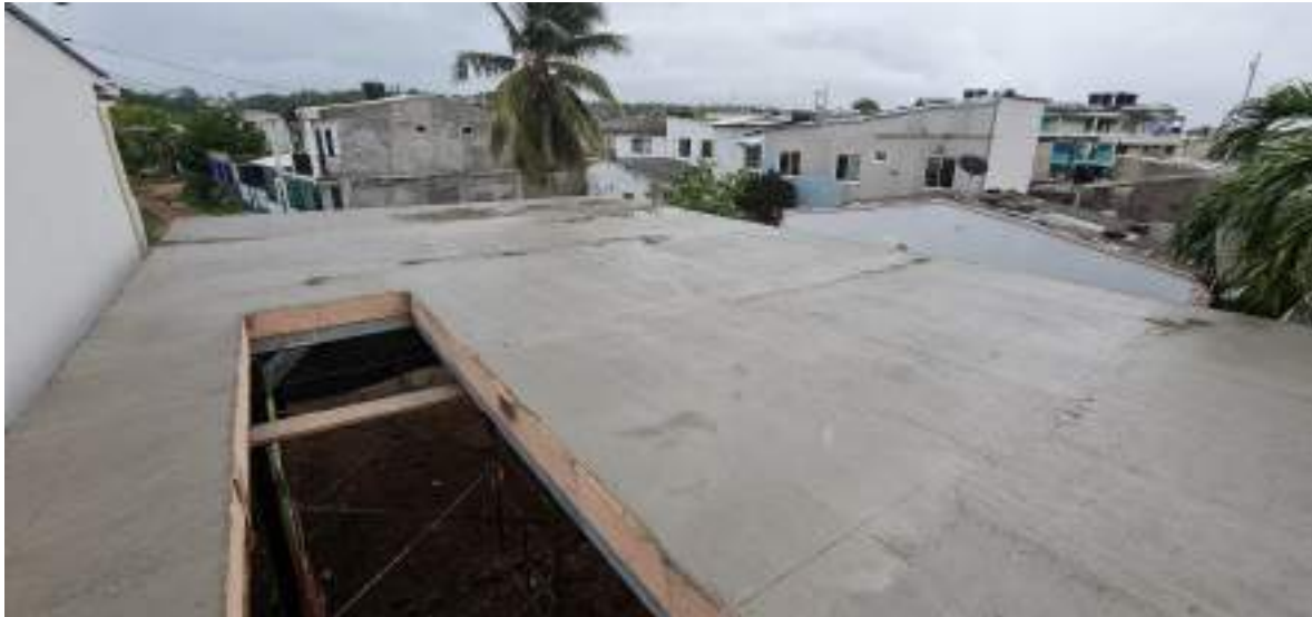
VISTA SUPERIOR DE PLACA VIENDO EL VANO DE LA ESCALERA
