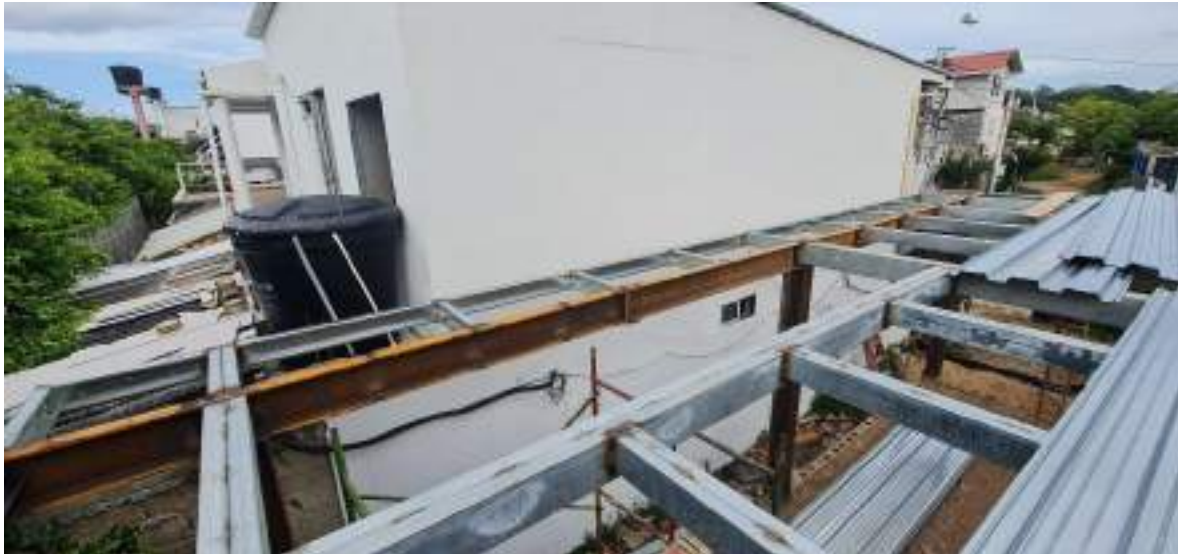
POSTERIOS INSTALACION DE METALDECK, INSTALACION 15 UND DE METALDECK
