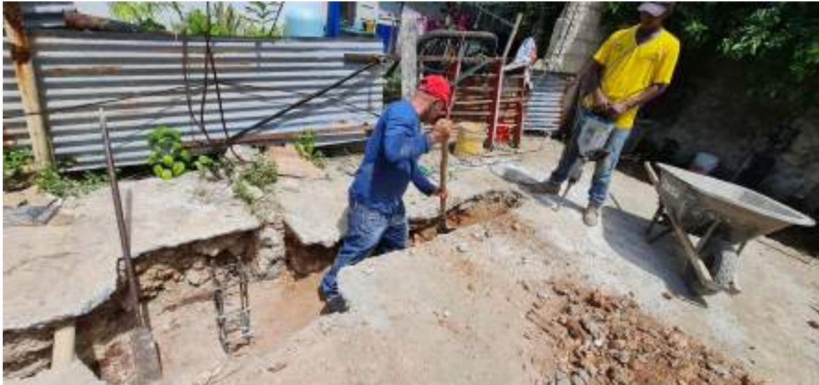
EXCAVACION EN PLACA,ALQUILER USO DE ROTOMARTILLO
