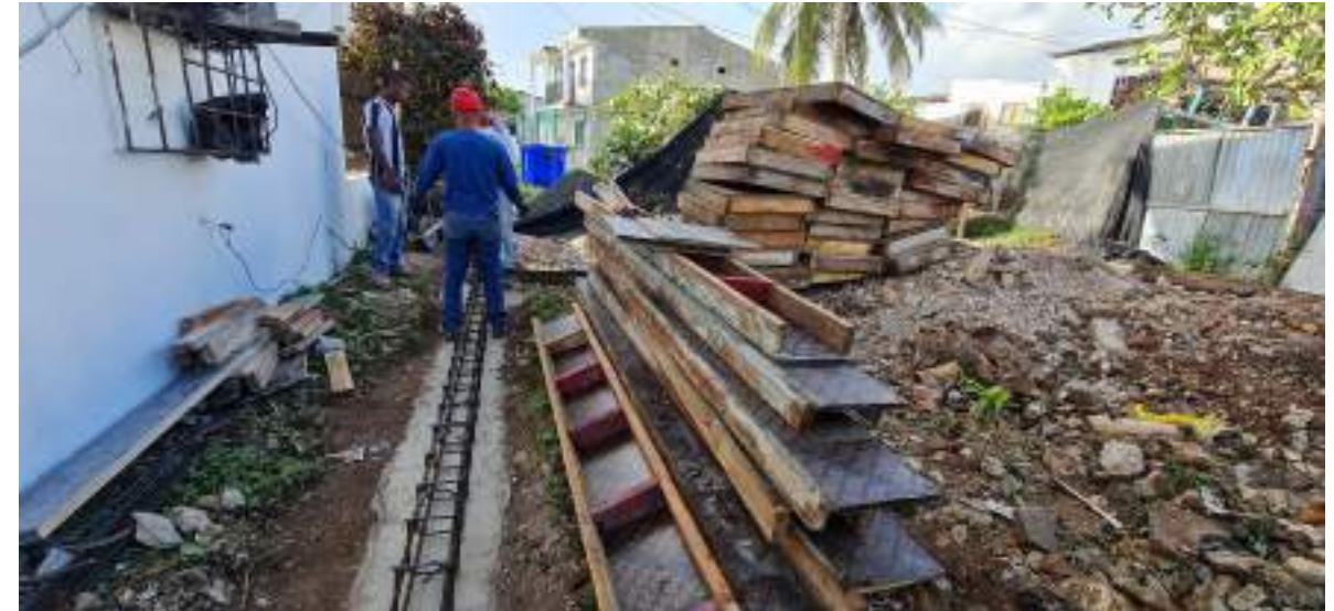
ARMADO DE HIERROS PARA VIGA CIMIENTO DE 25 X30. ALQUILER DE PLAFONES Y FORMALETA DE TRIPLEX ESTRUCTURAL
