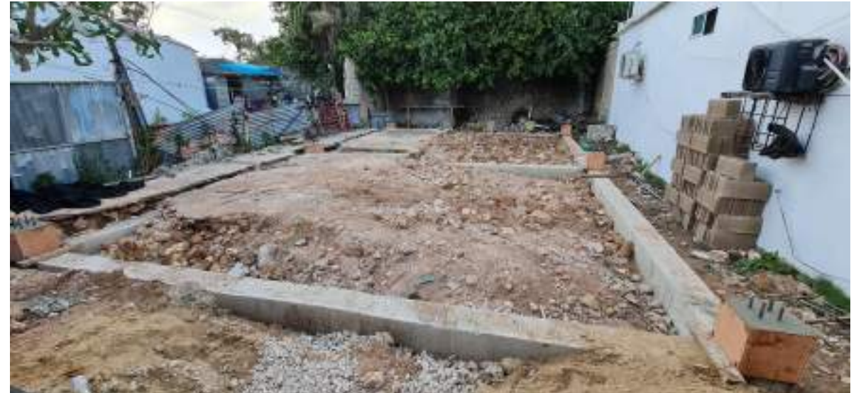
DESENCOFRADO DE VIGAS , ARMADO DE PEDESTALES Y FUNDIDO DE LOS MISMOS SE COMPRA BLOQUE NUMERO 15 , PARA ELABORACION DE CONTOURNO PARA RELLENO
