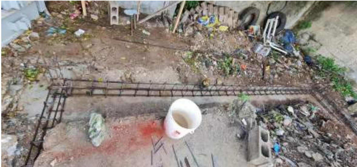
ARMADO DE VIGA SOBRE SOLAO, TRASLAPOS NO MENOR A 80 CM
