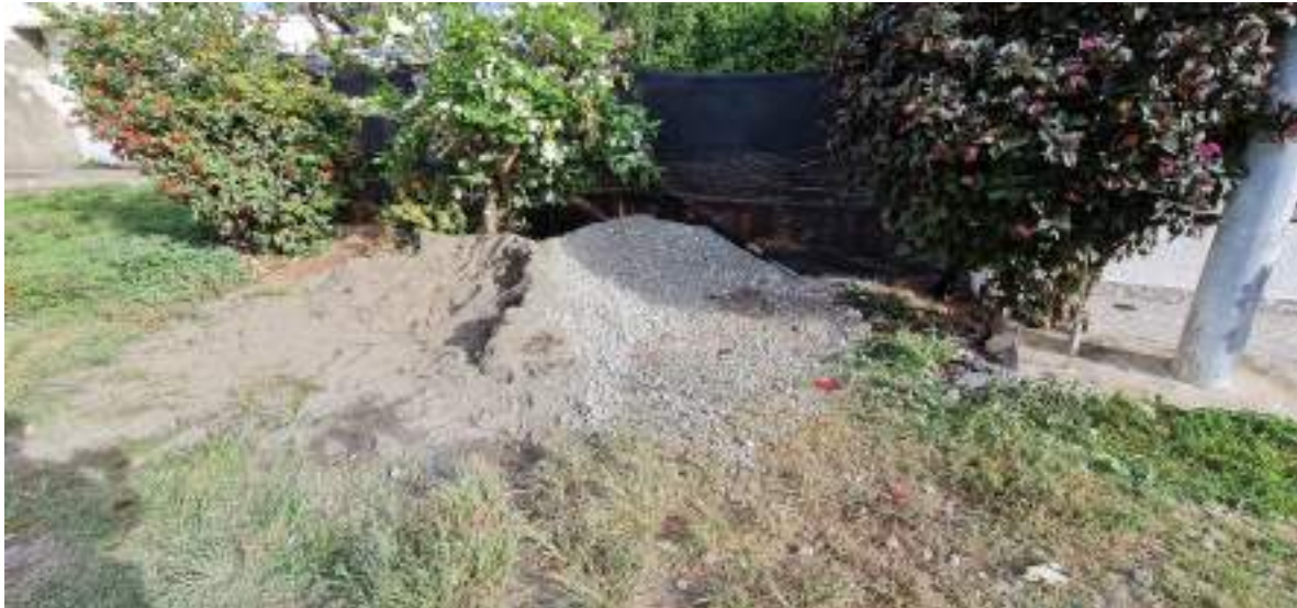
AREA DE DESCARGUE DE ARENA Y GRAVA, FUERA DE AREA DE CERRAMIENTO CON POLISOMBRA Y MARCO DE MADERA
