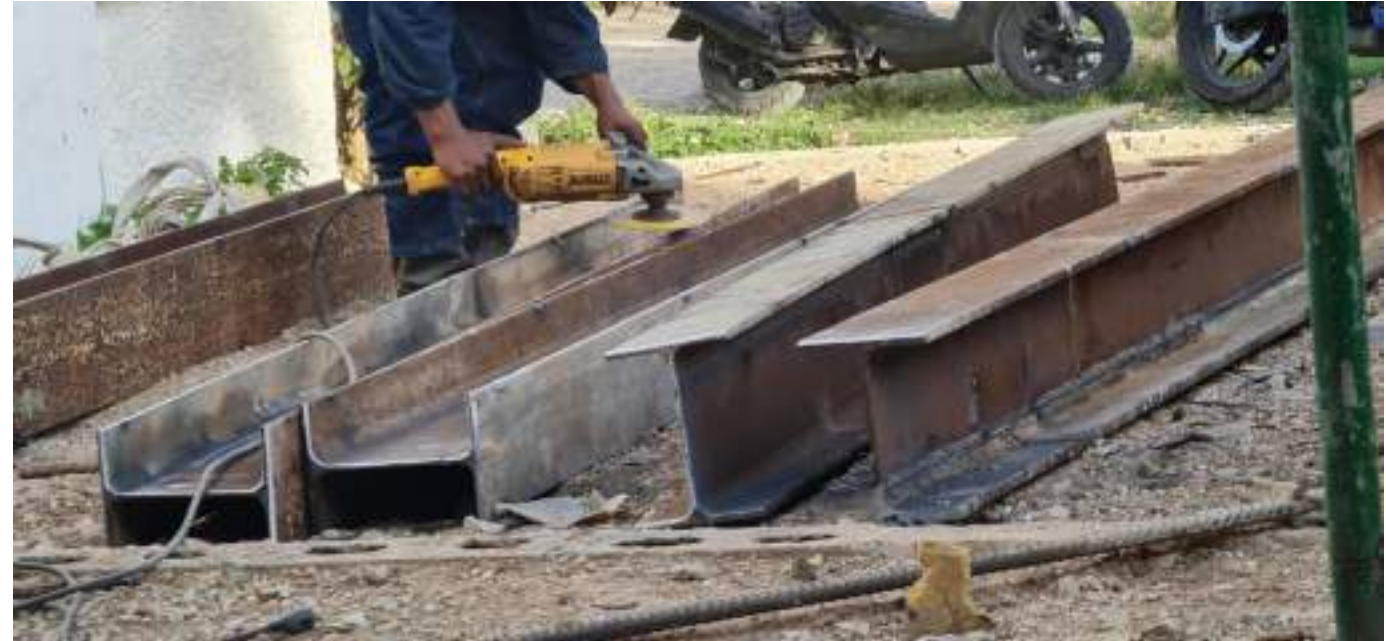
TORNO, BISELADO Y PREPARACION DE ESTRUCTURA DE COLUMNAS
