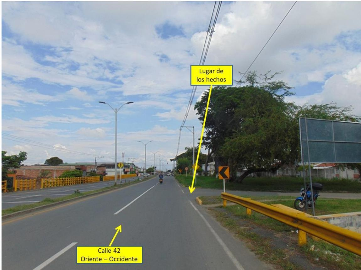
**FOTOGRAFÍA No. 4 PANORÁMICA:** En esta fotografía tomada por el equipo de IRS Vial en sentido oriente – occidente en la calle 42 a la altura de la carrera 3A, se aprecian las características generales de la vía en la cual se encuentra demarcación horizontal de línea blanca segmentada y líneas de borde, con señalización vertical delineadores de curva; en este sentido se desplazaban los vehículos.
