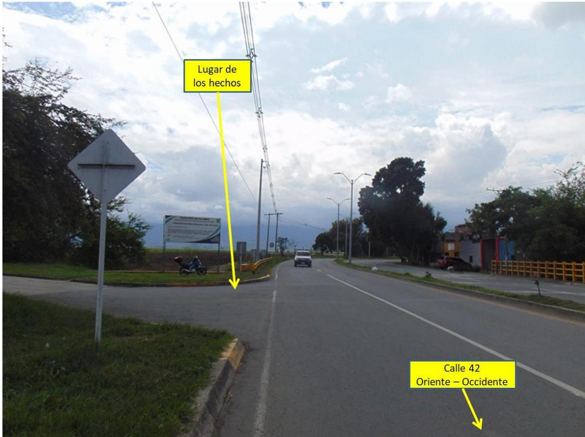
**FOTOGRAFÍA No. 5 PANORÁMICA:** En esta fotografía tomada por el equipo de IRS Vial en sentido occidente - oriente en la calle 42 a la altura de la carrera 3A, se aprecian las características generales de la vía en la cual se encuentra demarcación horizontal de línea blanca segmentada y líneas de borde, sin señalización vertical.
