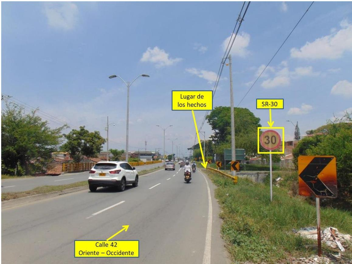
**FOTOGRAFÍA No. 2 PANORÁMICA:** En esta fotografía tomada por el equipo de IRS Vial en sentido oriente – occidente en la calle 42 a la altura de la carrera 4, se aprecian las características generales de la vía en la cual se encuentra demarcación horizontal de línea blanca segmentada y líneas de borde, con señalización vertical SR-30 “Velocidad máxima 30 km/h” y delineadores de curva; en este sentido se desplazaban los vehículos.
