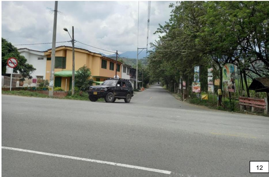
**Imagen No. 11 y 12. Condiciones de la vía nacional 3105 a la altura de la entrada y salida del corregimiento La Buitrera donde por el paso del tiempo la señalización horizontal se ha ido desapareciendo, así mismo debido a la cantidad de accidentes que se han presentado en ese sitio habían colocado reductores de velocidad antes de llegar a este sitio en ambos sentidos de la vía a unos 20 metros aproximadamente por ambos sentidos de la vía.**
