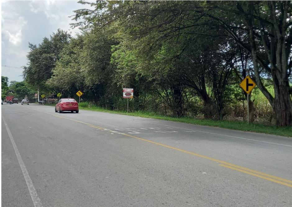
**Imagen No. 3. Condiciones de la vía nacional 3105 antes de llegar al cruce de la vía hacia el corregimiento La Buitrera en el sentido Santander de Quilichao a Palmira, donde se aprecian las señales verticales preventivas SP-13 “Vía lateral izquierda”, SP-03 “Curva pronunciada a la izquierda”, la señal SP-47 “Zona Escolar”.**
