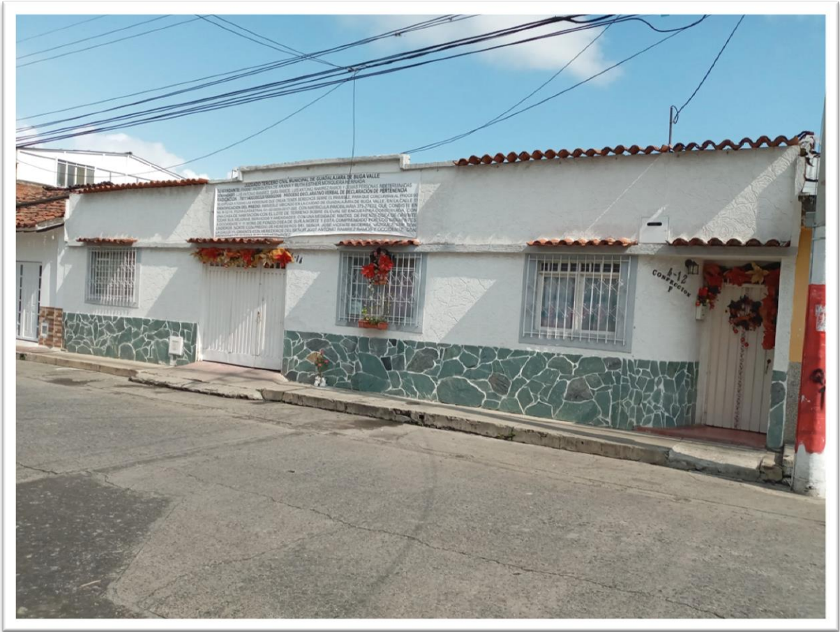
Foto 1. Fachada del predio con nomenclatura, Calle 11 N° 4-12 / 14. Valla emplazadora al proceso
