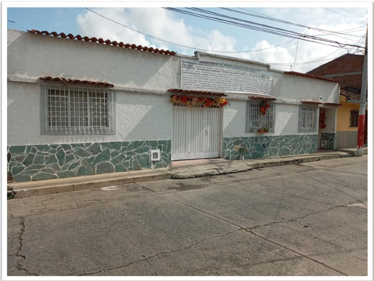
Foto 2. Fachada del predio con nomenclatura, Calle 11 N° 4-12 / 14. Valla emplazadora al proceso
