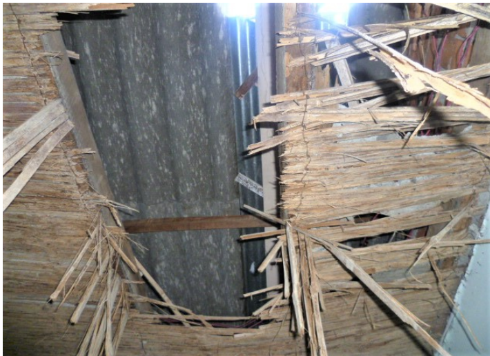
DETERIORO DE TECHO Y CIELO RASO
