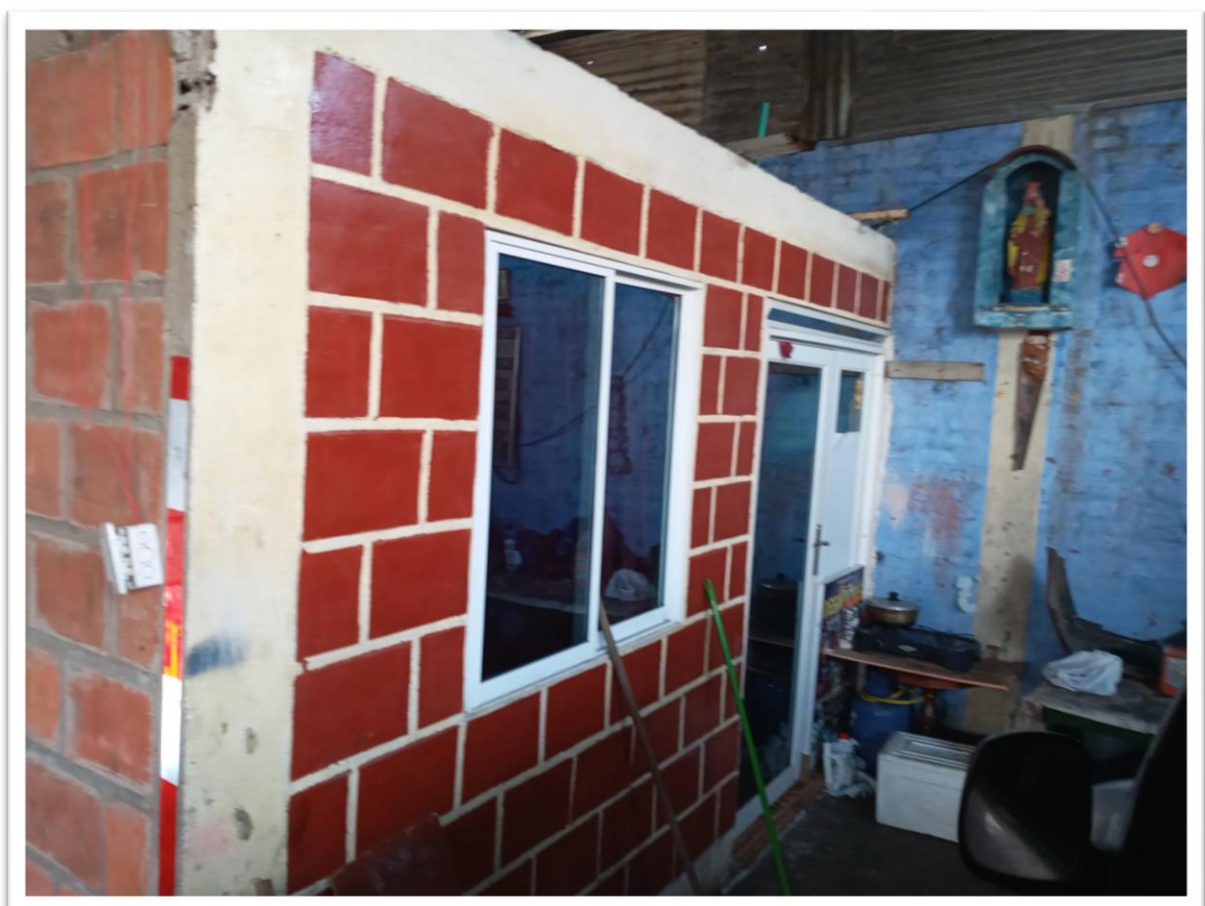
Foto 3. Primera planta, Interior del predio. Objeto solicitado en RECONVENCIÓN - DECLARACIÓN DE PERTENENCIA.
