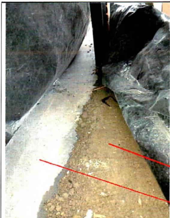
En la nueva losa construida en la terraza se puede evidenciar que en la parte frontal de la fachada la losa no fue terminada, y se evidencia las uniones del superboard utilizado, cabe señalar que por estas uniones se presenta ingreso de agua al tercer nivel. Se evidencia que la losa no cumple con un grosor adecuado.
