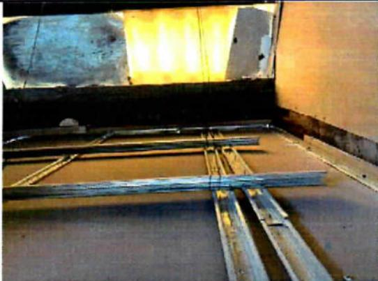
Se verifica que el cielo raso no fue construido correctamente según las indicaciones del fabricante y por este motivo en algunos espacios se tiene presencia de desnivel.
