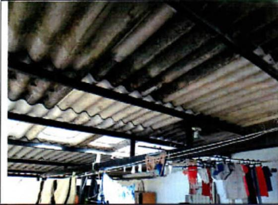
El ingreso de agua presentado en el tercer nivel se genera por la cubierta en fibrocemento de la terraza, esta tiene una pendiente no mayor a 27% que es la que recomienda el fabricante que debe ser implementada.
