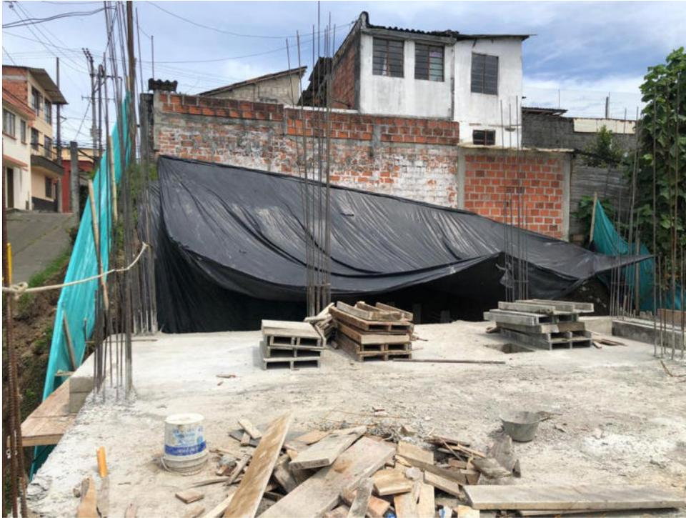
Se evidencia consecucion por parte de la constructora en el desarrollo del metodo constructivo, construyendo por fases de extraccion de tierra.
