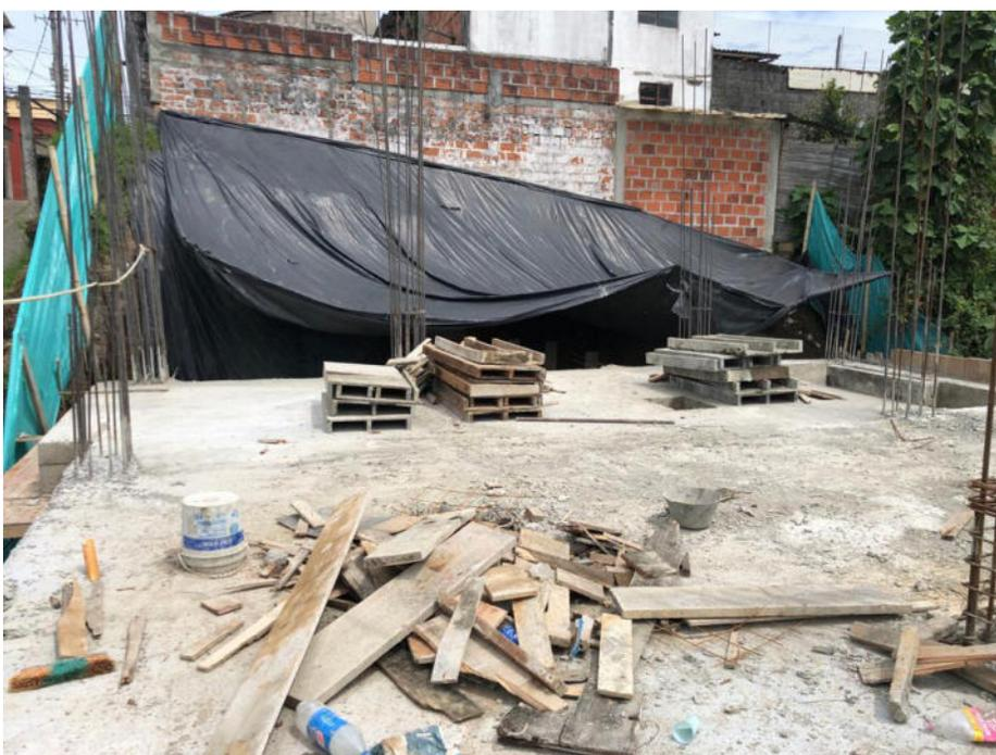
El muro está construido en mampostería tipo pega y bloques de arcilla, el cual no está integrado a la estructura de la vivienda, siendo solo un muro de cerramiento.
