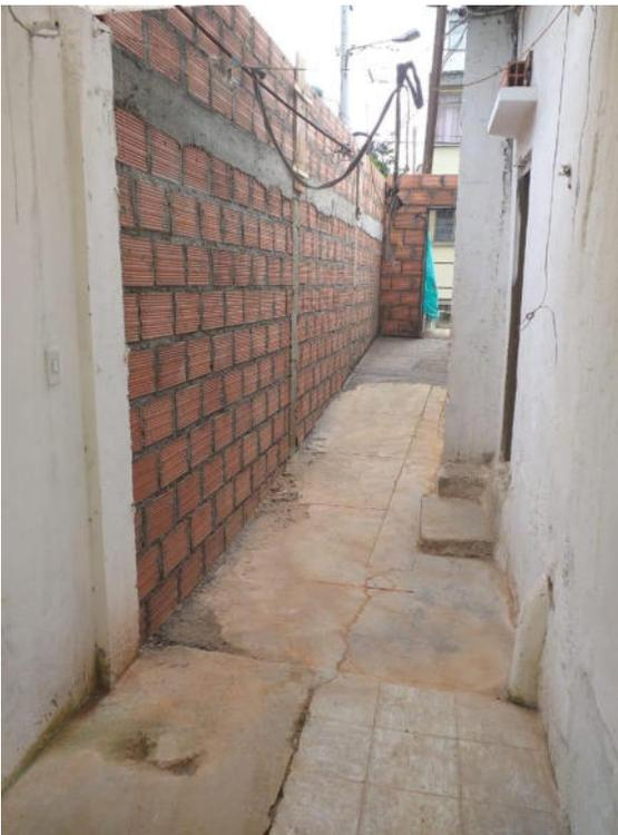
El muro de cerramiento se realiza despues de la demolicion controlada del resto del muro anterior existente y se realiza chequeo de niveles respeto al muro colindante que no se demolio el cual no presenta ningun tipo de desplazamiento ni afectacion. Por lo tanto demuestra que en ese sector del terreno no hubo movimiento alguno.
