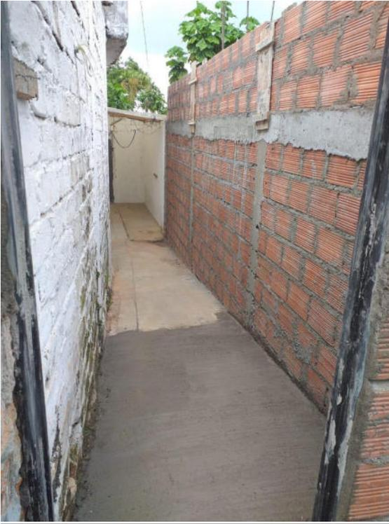
Durante la reparacion se hace reposicion del desplazamiento de tierra, y se repara el acceso a la vivienda, ademas de re construir el muro de cerramiento con una cimentacion aprobada por la NSR 10 y se construye el muro de cerramiento con todas las normas de construccion vigentes para cerramientos no estructurales.
