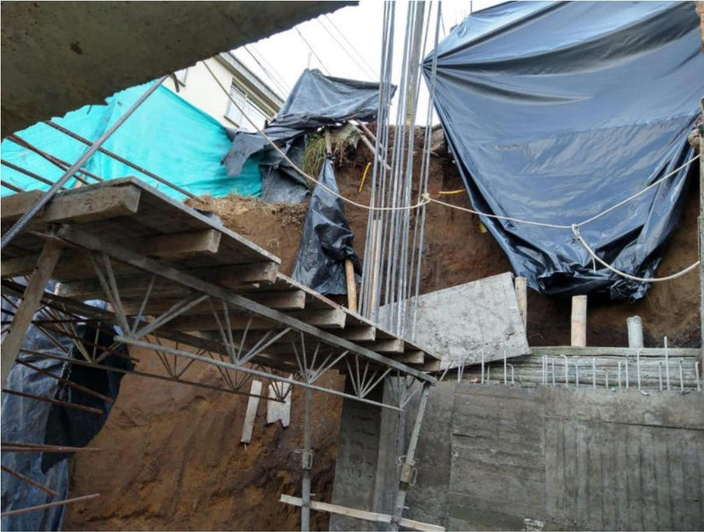
En el movimiento se afecta la circulación de acceso a la vivienda y un tramo de 2 metros del muro de cerramiento.
