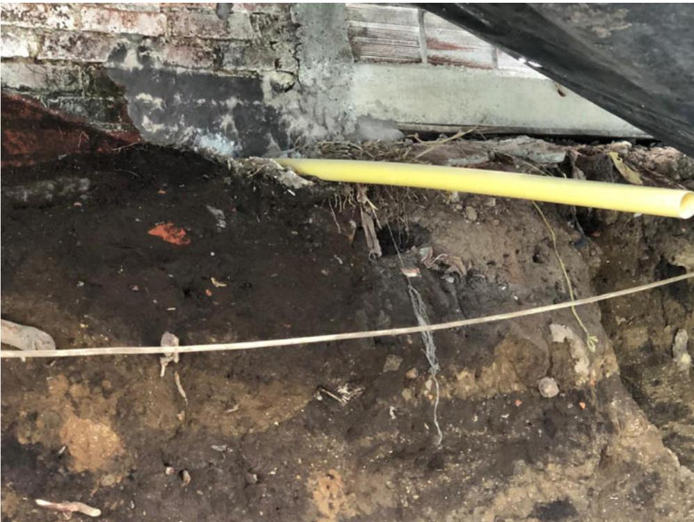
Se evidencian desagues del interior de la vivienda que pueden presentar afloraciones y filtraciones afectando la condicion del muro de cerramiento de la edificacion colindante.
