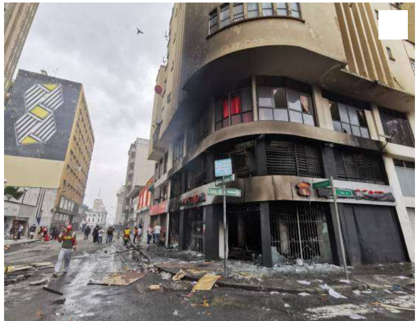
La sucursal del banco Davivienda, ubicada en la Carrera 5 con Calle 10, en el centro de Cali, fue incinerada. José Luis Guzmán - El País
