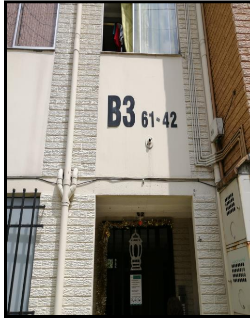
F.2 Acceso al edificio
