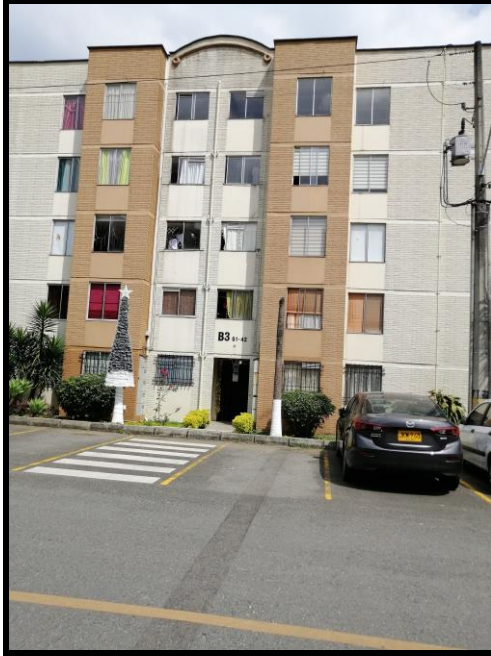
F.1 Fachada del bloque 3
