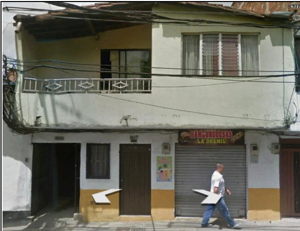
Foto 1: Fachada y acceso exterior
