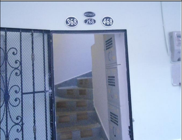
Foto 4: Acceso 2°, 3er y 4° piso
