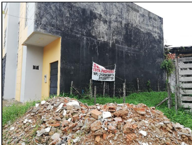
Calle 3ª Entre Carreras 10ª y 11ª
