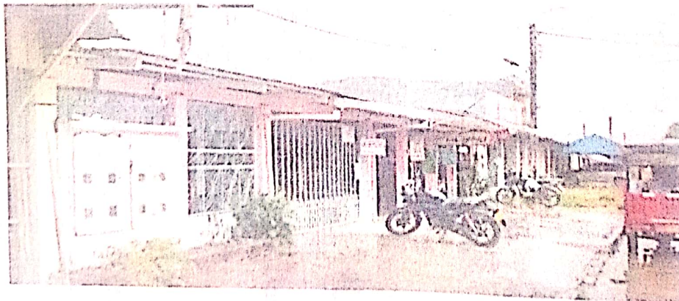
FOTO FACHADA TOMA 2
