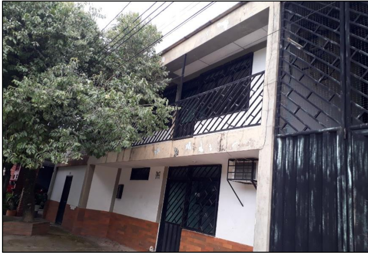
LADO DE SU FACHADA PRINCIPAL
