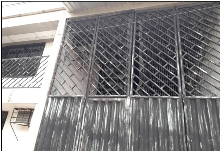
ACCESO A LA BODEGA
