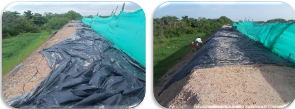
Imagen 24. Reacomodamiento de plásticos del costado de los diques.
