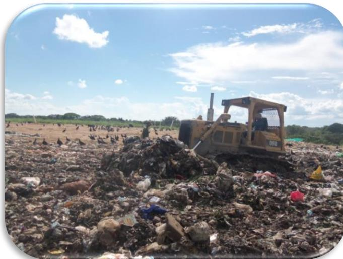
Imagen 3. Extendida de los Residuos Sólidos Mediante el Buldócer.
