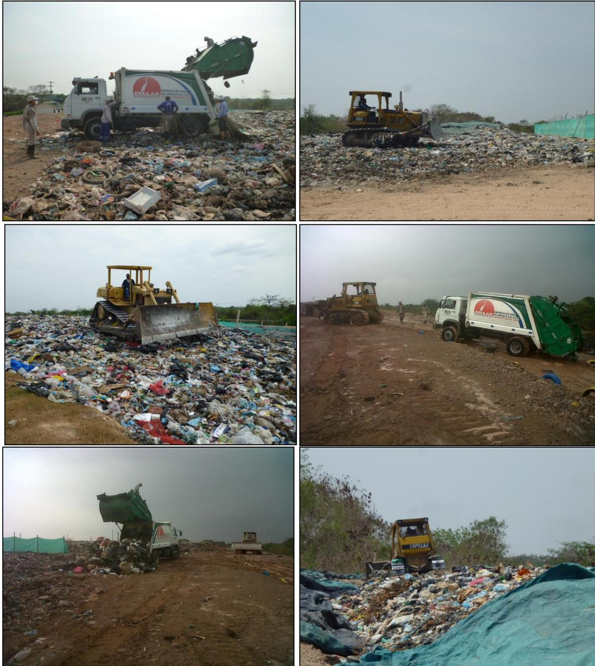
Foto 1 – 6. Operación de frente de trabajo en la zona de ampliación de la celda.
