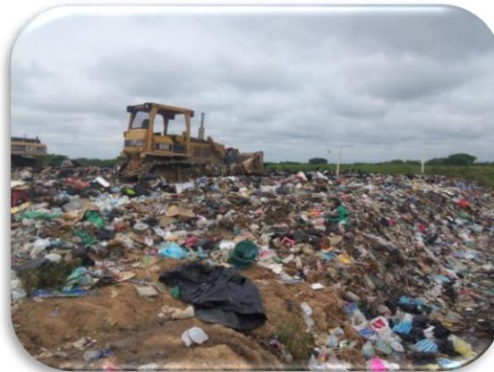
Imagen 4. Compactación de los Residuos Sólidos Mediante el Buldócer.
