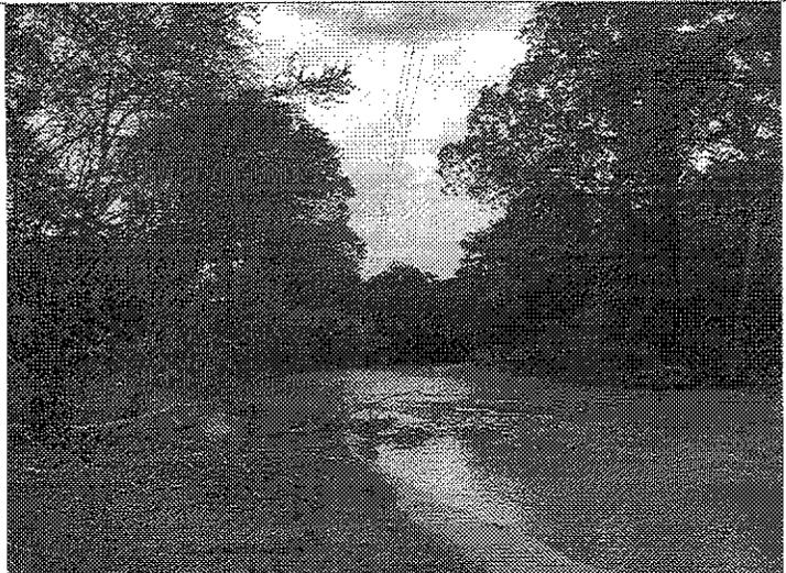
**IMAGEN 013.** Se observa vano con tres conductores ACSR entre las estructuras número 3495061 de Enertolima y la estructura poste No. 220 de Enertolima con ramas de árboles cercanos a los conductores. Toma hecha hacia el lado de la escuela
