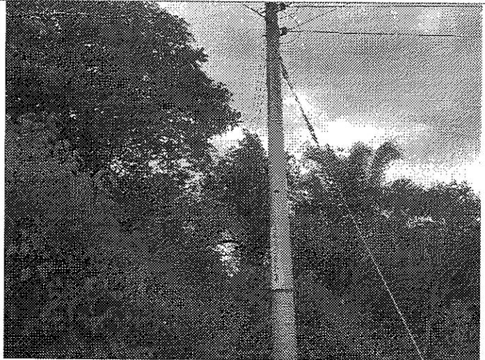
**IMAGEN 11.** Complemento imagen 10 Se observa estructura eléctrica consistente en un poste de fibra identificado con el número 3495061 de Enertolima, vestido con perchas y templetes con tres conductores ACSR estructura desde donde parte el vano que pasa sobre el rio Tuluni lugar del hecho.
