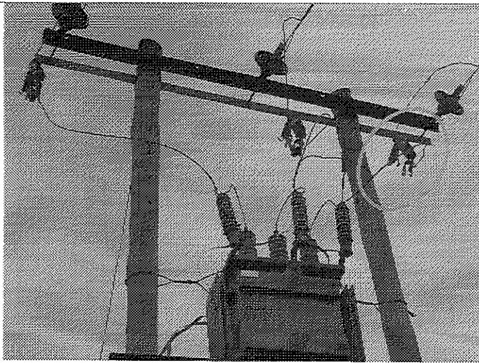
**IMAGEN 07.** Se observa en la parte posterior del transformador fecha de vencimiento 04-17 y en círculo color anaranjado protección abierto sin el correspondiente termofundente que alimenta en alta el transformador
