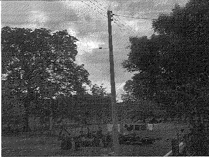
IMAGEN 021. Se observa estructura de paso de ramal con tres conductores ACSR punto de conexión al usuario Mario Méndez con código de cuenta 417482
