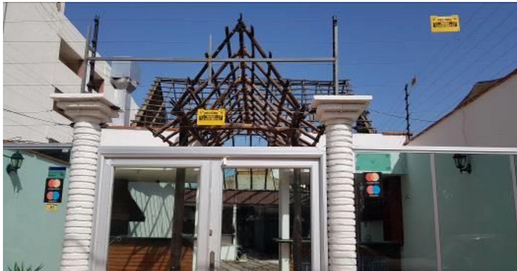
Local donde operaba el restaurante y que resultó afectado por el incendio
