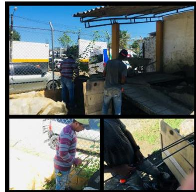
6. Mampostería en bloque H10: construcción de todos los muros en bloque H10 con mortero de pega 2:1.
