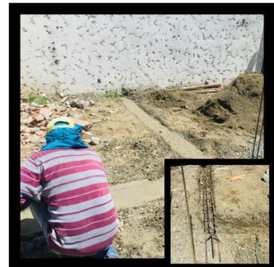
3. Concreto de 3.000 psi para columnetas y vigas de cimentación: construcción de columnetas, vigas fundidas en concreto simple, y comprenden la elaboración y colocación de refuerzo y otros elementos embebidos en el concreto, la colocación del encofrado, vaciado del concreto, retiro de la formaleta y curado.
