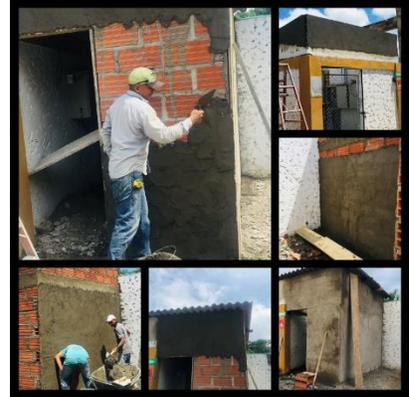
8. filos y dilataciones: suministro y mezcla y aplicación de morteros par filos y dilataciones de la edificación.
