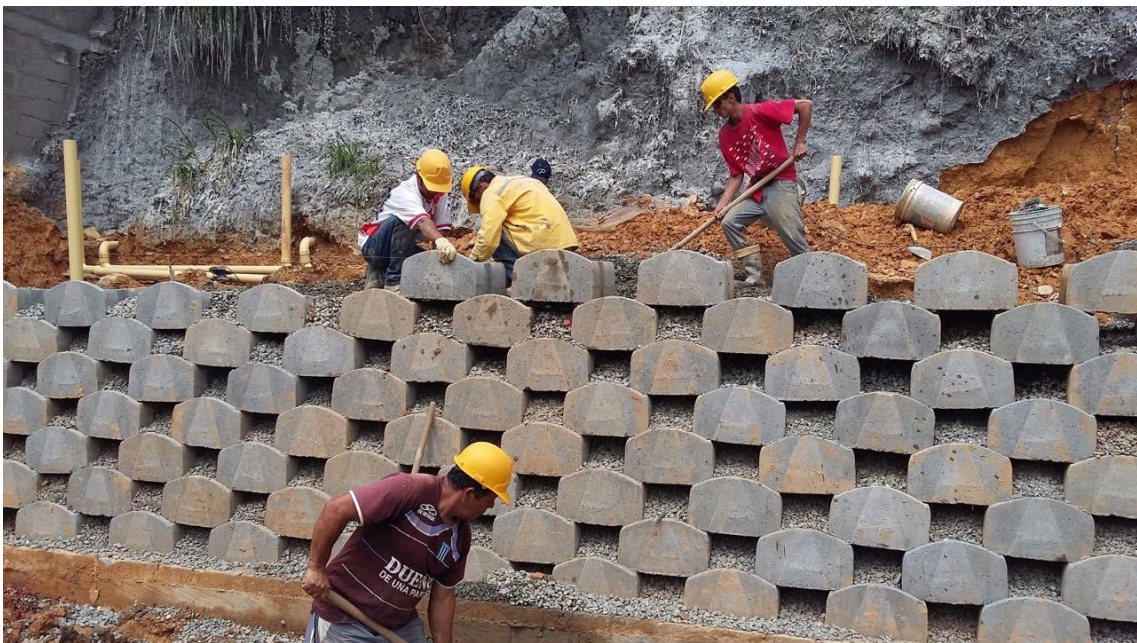
Proceso de construcción del muro con sus respectivos filtros.
