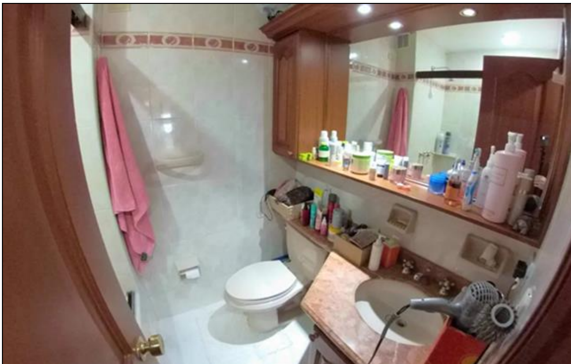
FOTO No. 05: Panorámica del baño privado de la alcoba principal del Apartamento Tipo visitado para mostrar la puerta de ingreso en madera, los muros y pisos totalmente enchapados, accesorios sanitarios en buen estado de conservación.
