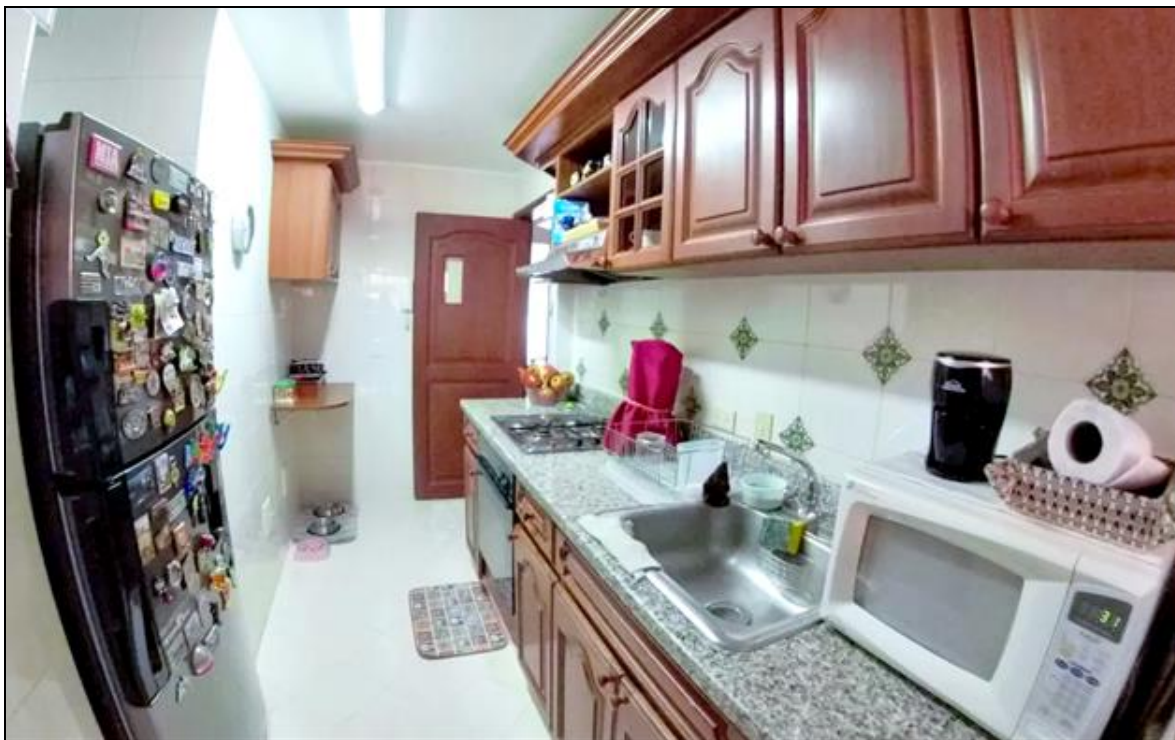
FOTO No. 07: Vista de la cocina del Apartamento Tipo visitado, para mostrar los terminados básicos en muros enchapados totalmente; con presencia de lavaplatos en acero inoxidable, y gabinetería superior e inferior, con espacio para nevera, con zona de ropas.
