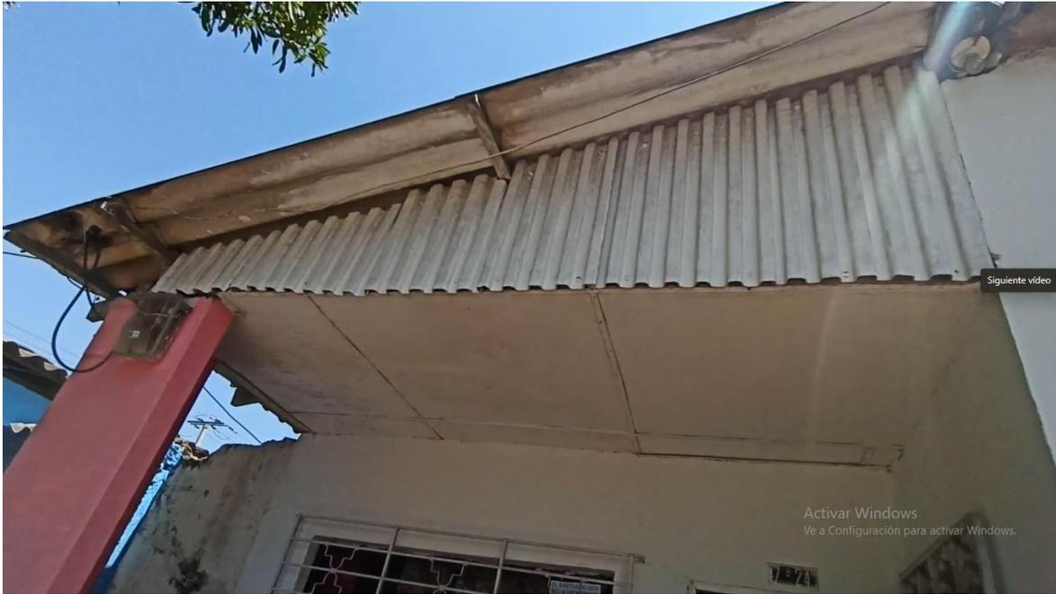
**PAREDES DEL FRENTE CON HUMEDAD PAÑOTE DETERIORADO Y PINTURA DAÑADA**
