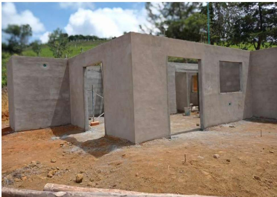
Foto 2: Fachada posterior, lado Norte, terminación de muros frisados en cemento allanado. Vanos de ventanas de dos alcobas y cocina.
