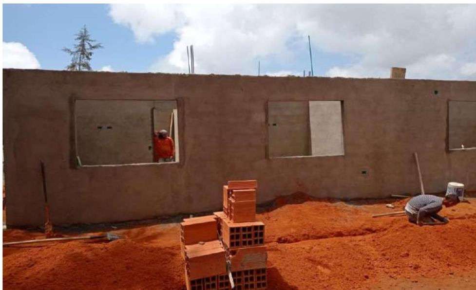
Foto 3: fachada lado Oriental, lateral derecha, muros terminados en mampostería de ladrillo con friso de cemento allanado a la altura de Viga Corona.
