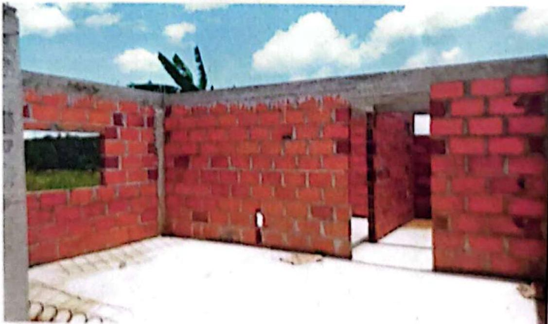
Foto 7: Vista interior Alcoba principal, muros terminados en mampostería de ladrillo hasta altura de vigas de amarre, vista de los vanos de puertas.
