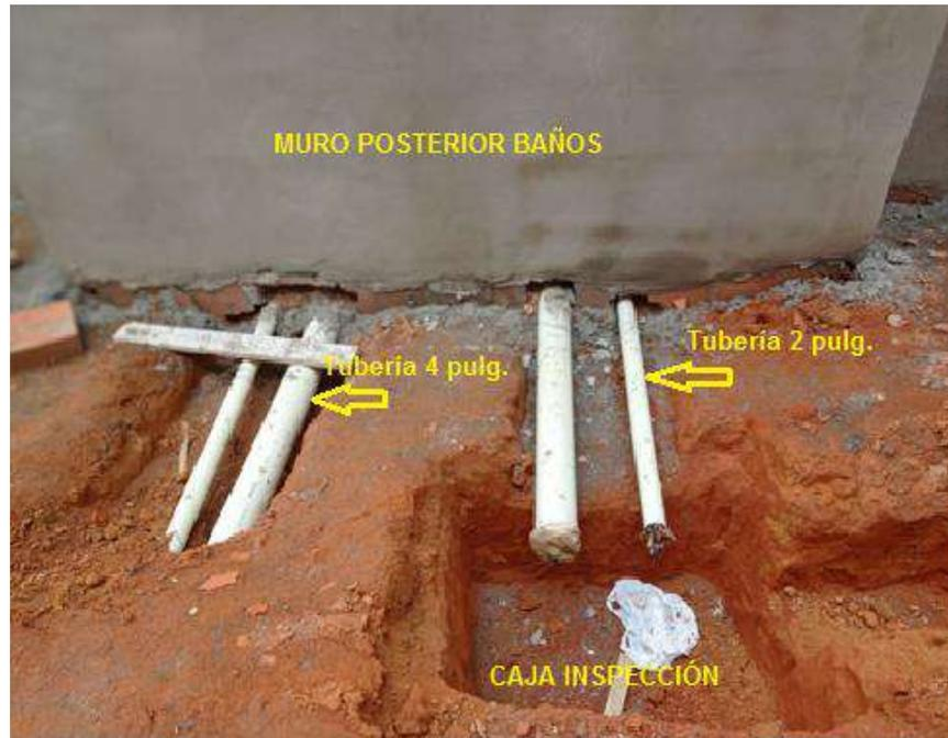
Foto 17: Vista de las tuberías Conduit correspondiente a las instalaciones eléctricas, sin cableado, no accesorios.
