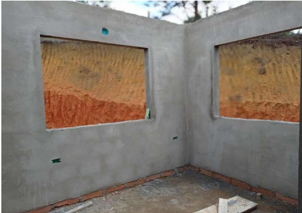
Fotos 8: Foto Alcoba 3 con muros terminados en mampostería de ladrillo y friso de cemento allanado liso a la altura de Vida de amarre Corona. Vanos ventanas.
