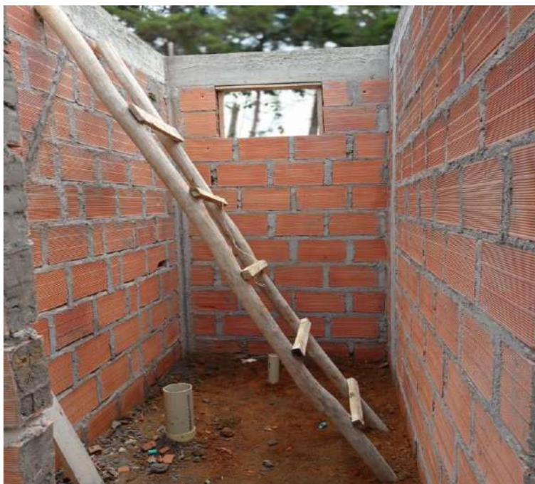
Foto 12: Vista muro interior lado Occidental de la Cocina y Labores, fondo en proceso de apertura de canales para colocación de tuberías.
