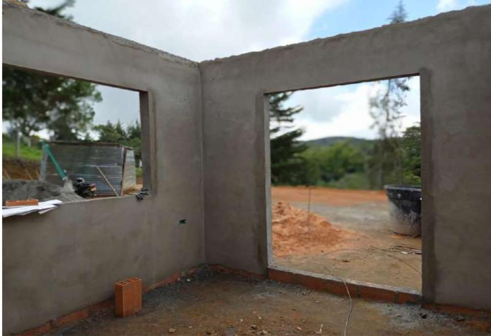
Foto 6: Vista interior del Comedor hacia la zona de piscina. Muros terminados en mampostería de ladrillo con friso de cemento allanado.
