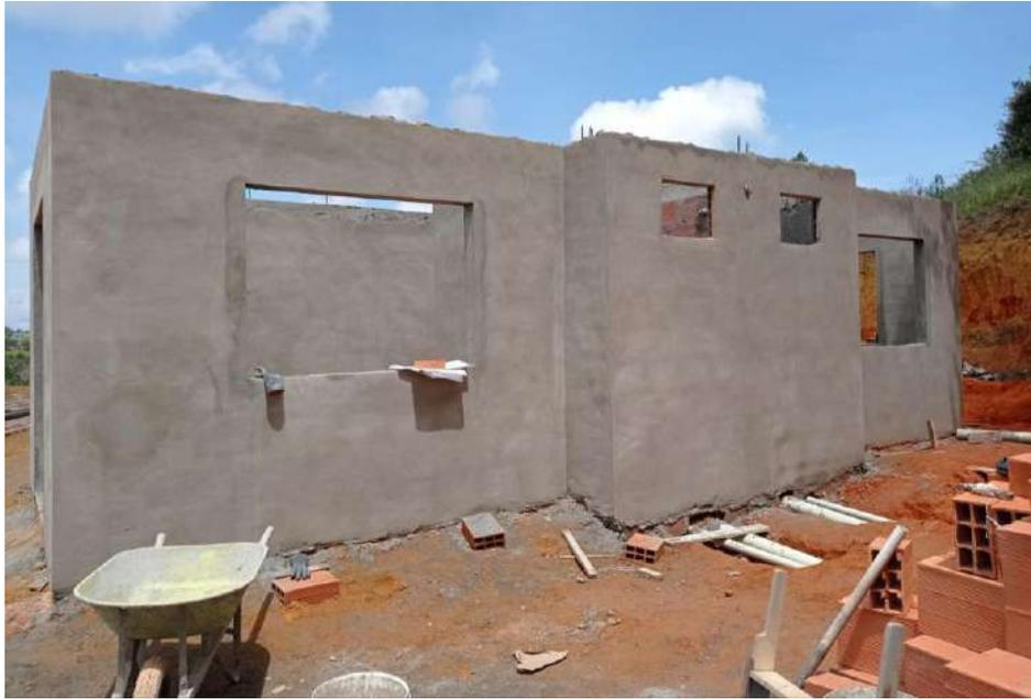
Foto 4: Vista fachada lado Occidental zona salida de comedor a piscina, muros terminados en friso de cemento allanado a la altura de viga Corona.
