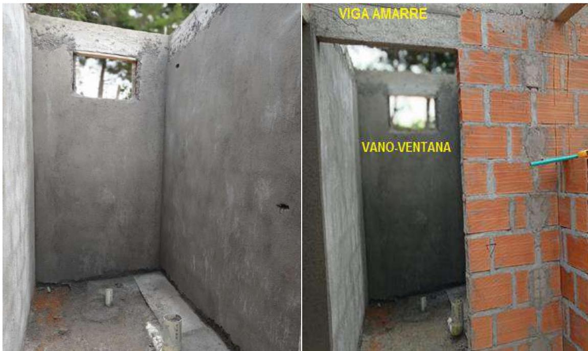
Fotos 11: Vista de los muros interiores del baño No.2 que se encuentra en proceso de preparación para la colocación del friso de cemento allanado.
