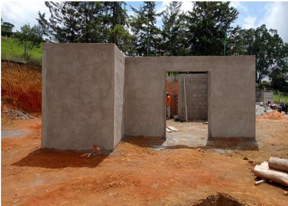
Foto5: Vista interior desde la Sala hacia la puerta de acceso. Muros terminados en friso de cemento allanado semi-liso.
