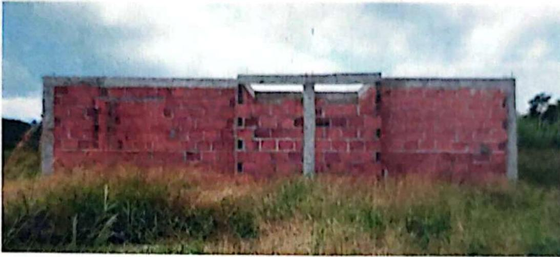
Foto 4: Vista fachada lado Este zona habitación, muros terminados en ladrillo H:10 a la altura de viga Corona, vanos de ventanas y columnas esquineras en concreto reforzado.
