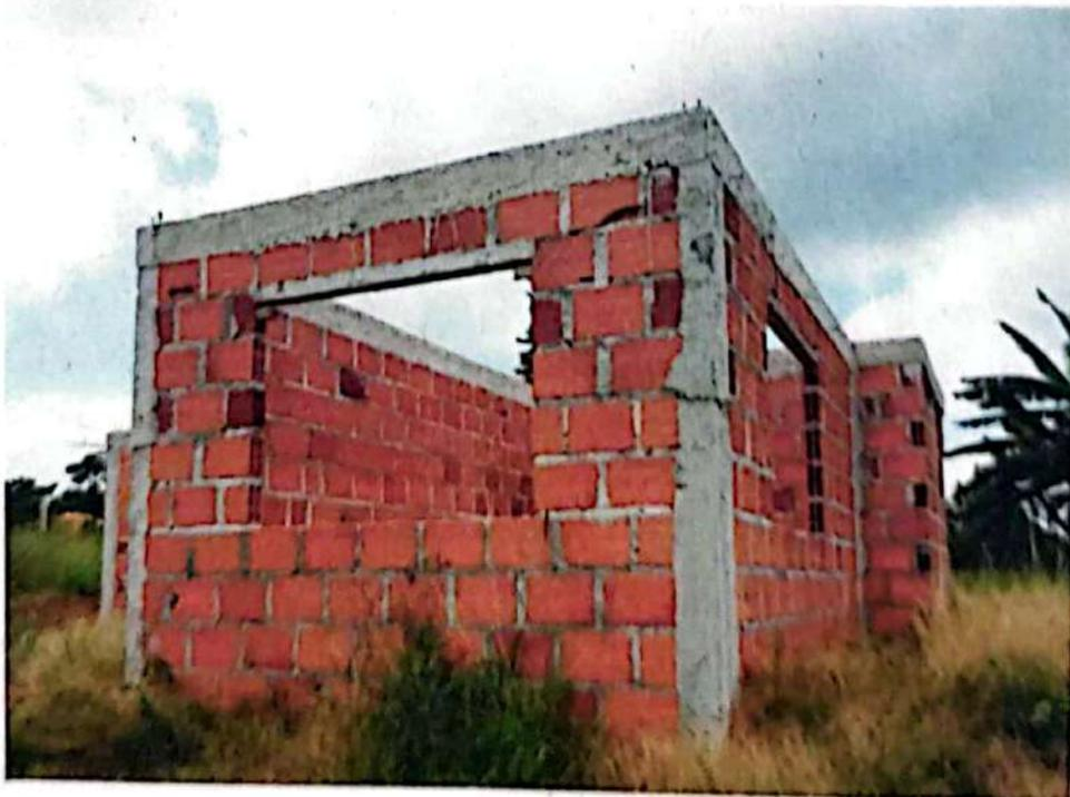
Foto 5: Vista interior desde la Sala hacia la puerta de acceso y ventana fachada. Muros terminados en ladrillo hasta la altura de viga Corona, plantilla de mortero para piso.
