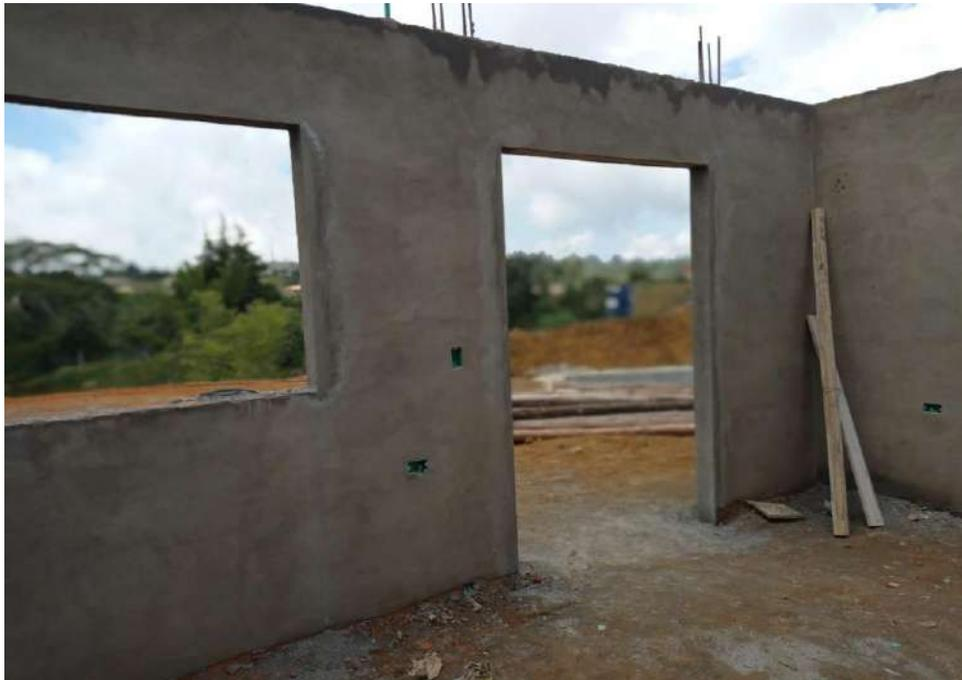
Foto 7: Vista interior Alcoba 2 esquinera, muros terminados en mampostería de ladrillo con friso de cemento allanado, vanos ventanas.
