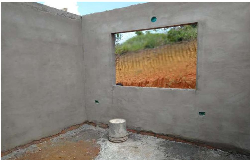
Fotos 9 y 10: Vista Baño No. 2 terminado en mampostería de ladrillo h-10 y friso de cemento allanado liso. Proceso de terminación friso.
