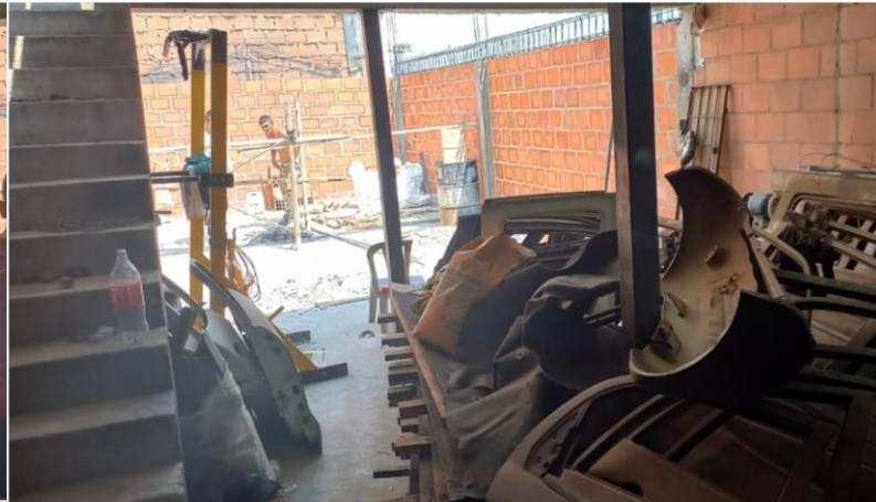
MESÓN Y LAVAPLATOS EN ESTRUCTURA METÁLICA.
