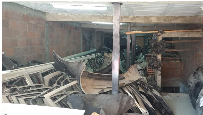
PUERTA DE ACCESO METÁLICA Y VENTANA A UN ÁREA DE BODEGA
