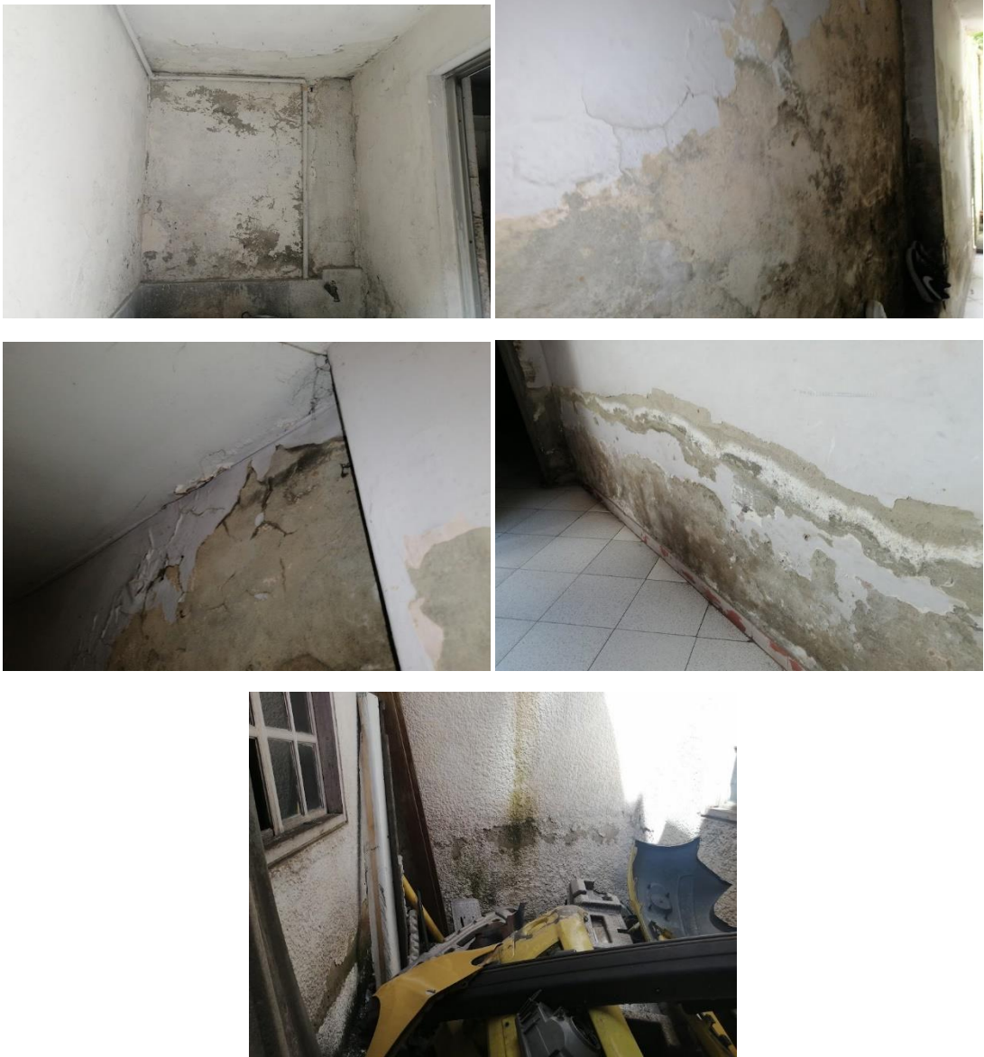
Estado de muros
